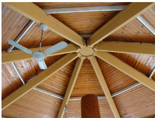
Figura 5 – Estrutura da cobertura em pré-moldado e forro de cedrinho na Pousada Araraúna.
