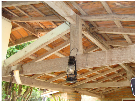
Figura 4- Estrutura da cobertura da casa sede, na Fazenda São Geraldo.
