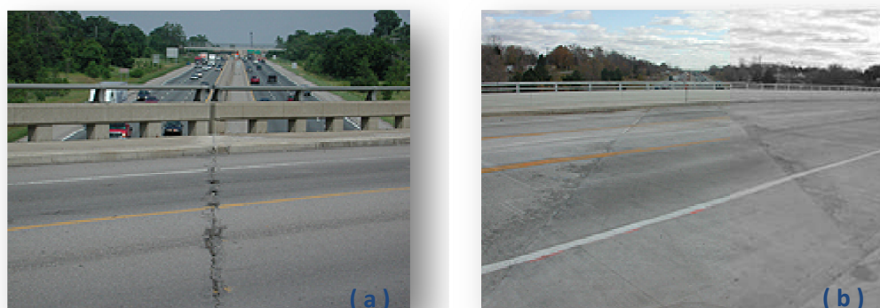
Figura 2.33: (a) Junta de ligação e (b) laje de ligação em ECC, localizada na Grove St., em Ypsilanti, MI, finalizada em Julho de 2005.
