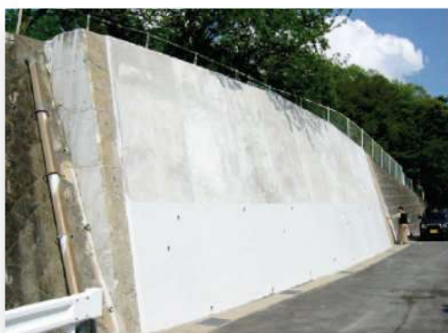
Figura 2.36: Muro de contenção, um ano após a execução do reparo em ECC [Rokugo et al. , 2005]
