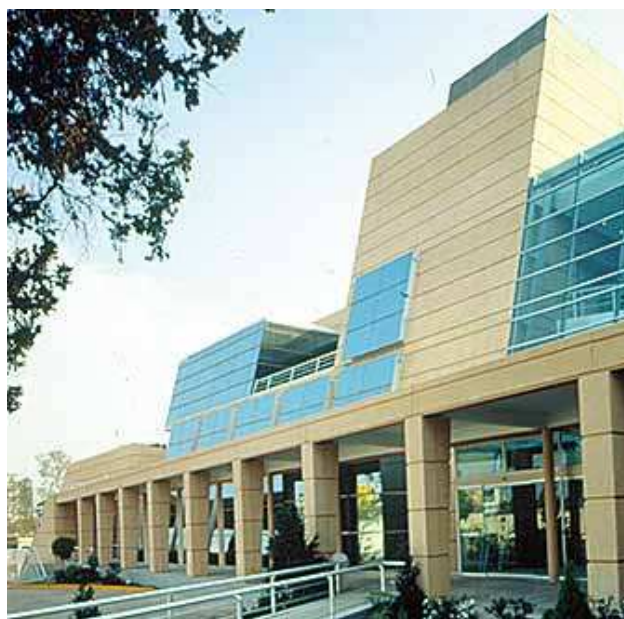
Figura 7 – Edifício BMS – Cidade do México [Fonte: Projeto Design]
