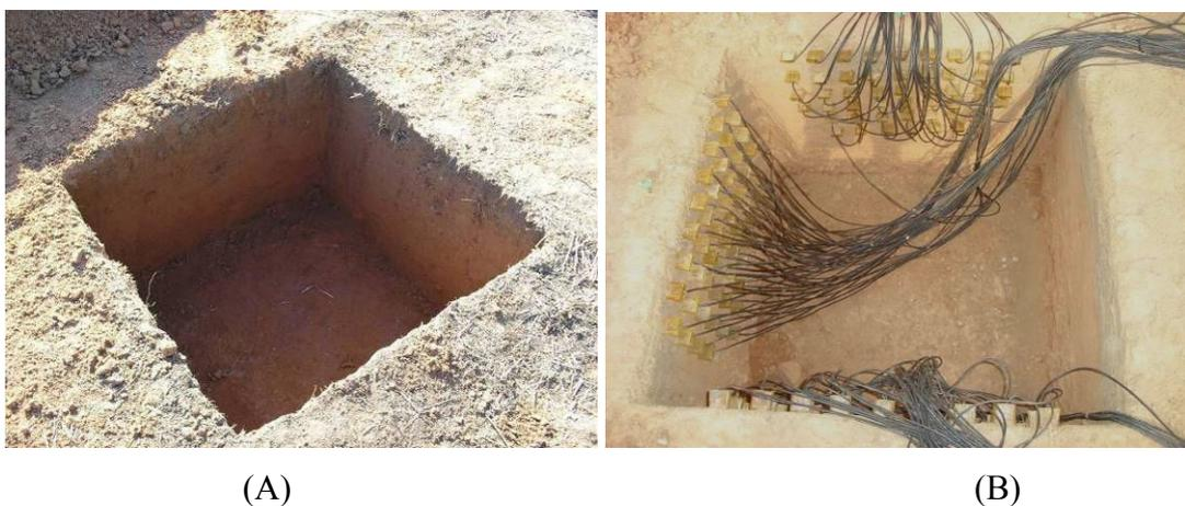
Figura 4A - Trincheira aberta para a instalação das sondas de TDR 4B - Disposição final das sondas instaladas
