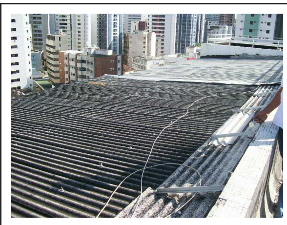
Fonte: Pesquisa de campo Fig. 7.14 - Cobertura de fibrocimento sobre área de pergolados - Obra C
