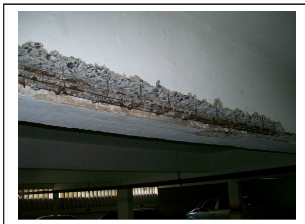
Fig. 7.20 - Demolição da estrutura de concreto armado sem escoramento adequado
