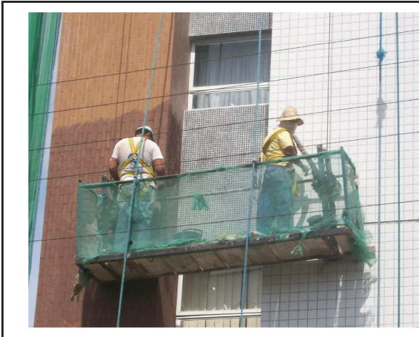
Fonte: Pesquisa de campo Figura 4.2 - Andaimés suspensos mecânicos
