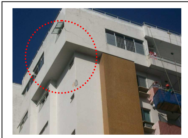
Fig. 7.12 - Detalhe arquitetônico do edifício que dificulta acessibilidade à fachada – Obra C
