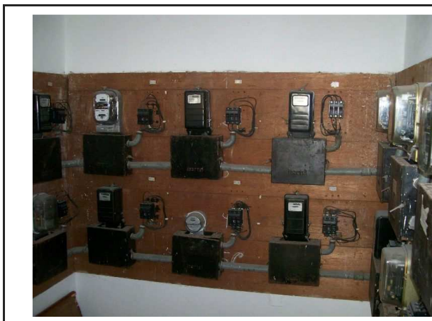
Fig. 7.1 - Quadro de medidores com instalação inadequada - Obra C
