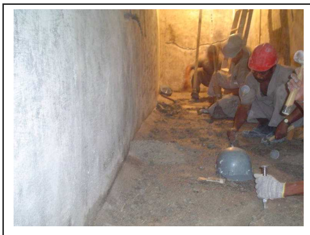
Fig. 7.5 - Serviços de manutenção na caixa d'água inferior da edificação – Obra H
