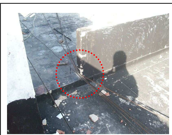
Fonte: Pesquisa de campo Fig. 7.16 - Fricção do cabo com possibilidade de rompimento - Obra C
