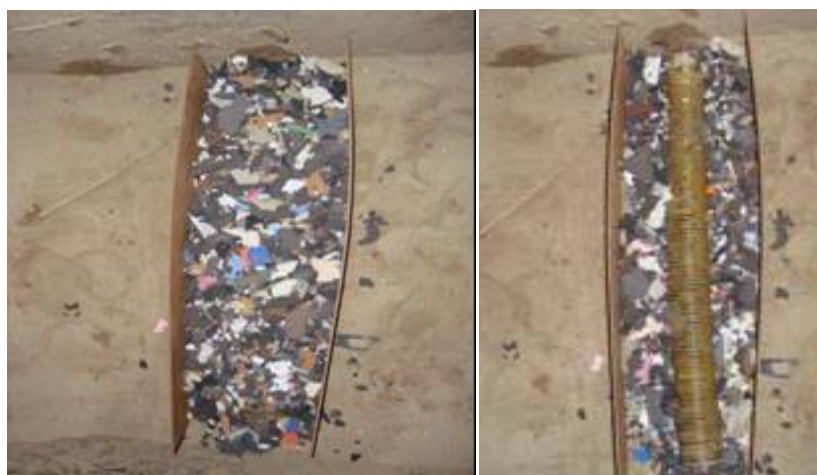
Figuras 9 e 10 Montagem dos tubos nos tanques utilizando-se envoltório de borracha
