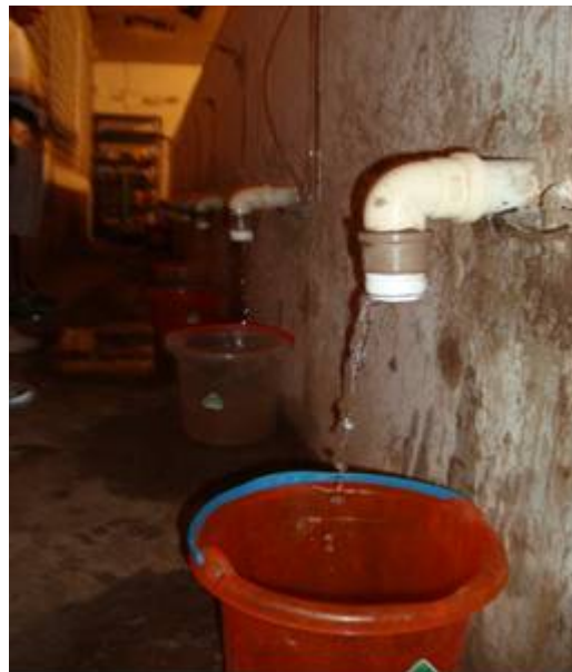
Figura 5 Tubo PVC rígido de 0,25 m de comprimento, com tampa roscável – ponto de descarga
