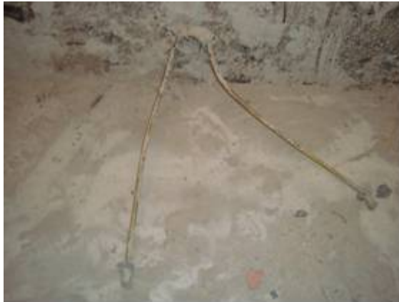
Figura 2 Dreno tubular corrugado para servir de encaixe ao tubo drenante
