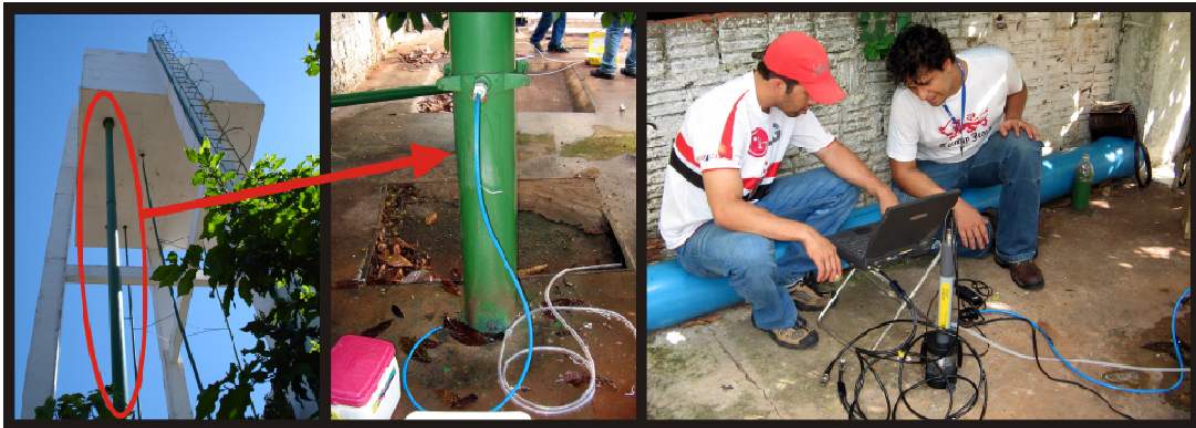
Figura 5.28 - Ponto de instalação da sonda 1 (Setor B).
