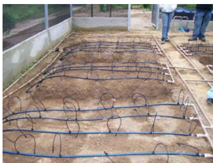
(a) montagem das linhas de irrigação
