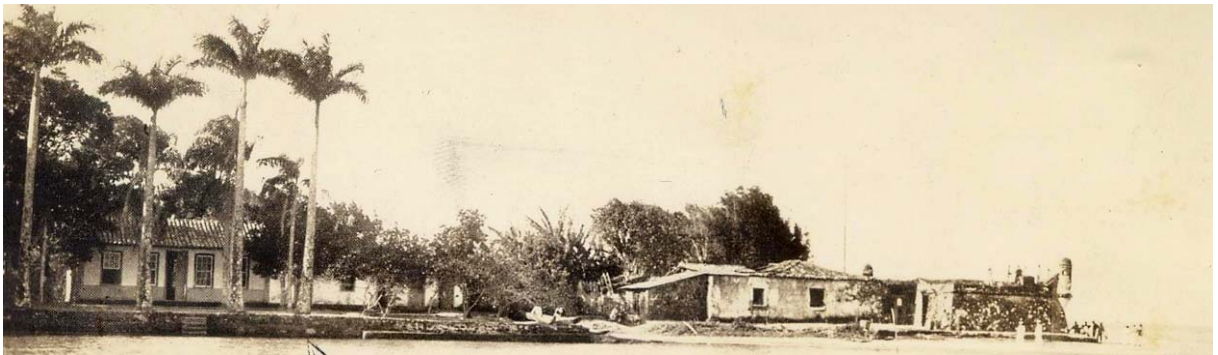
Figura 21. Vista geral do Forte São João
