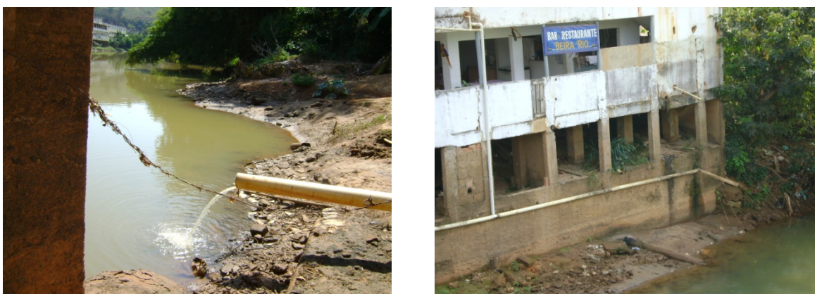
Figura 3.7 – Lançamento in natura de efluentes nas margens do Rio Pomba (Imagens obtidas durante a primeira campanha de campo, em outubro de 2008).
