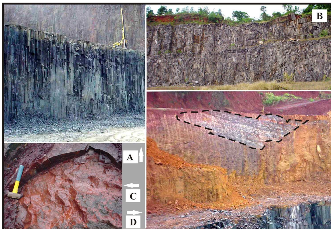
FIGURA 2 - Aspectos de sills na área de estudo. (A) Diaclasamento vertical estreitamente espaçado ("basalto palito") em um sill espesso (Pedreira Bela Vista). (B) Sill espesso com diaclasamento predominantemente horizontal (Pedreira Mottola). (C) Contato de sill espesso com a encaixante (arenito argiloso), com pequenas irregularidades (Pedreira Carollo-Pesqueiro). Marreta com 26 cm. (D) Xenólito decamétrico de rochas sedimentares encaixantes que "afundou" do topo para dentro do corpo intrusivo, que está profundamente alterado na porção superior (Pedreira Carollo - Passo da Amora). Fonte: autor.
