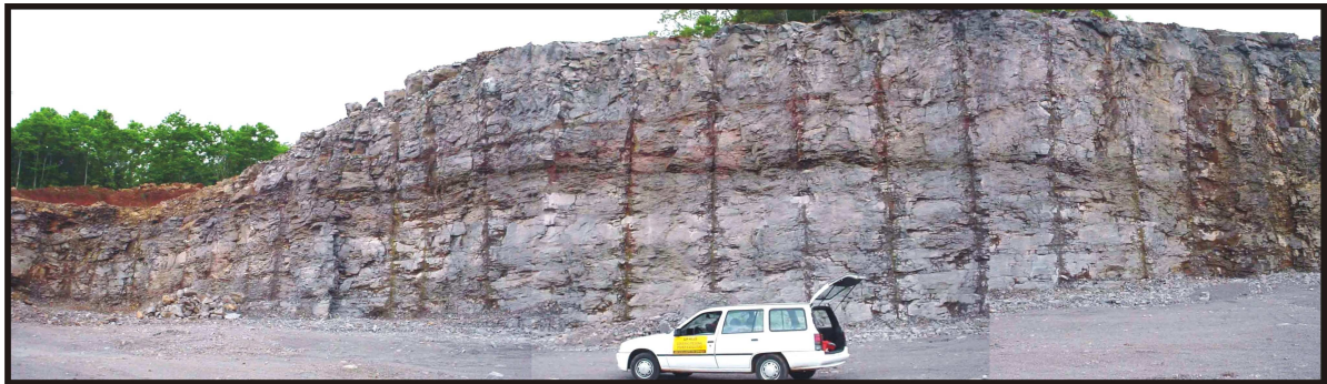
FIGURA 6 - Feição interpretada como junta-falha, pela notável semelhança com várias das imagens publicadas de juntas-falha. Trata-se de faixas cizalhadas sub-horizontais, de espessuras variadas, que seguem um padrão entrelaçado. Traços escuros verticais são furos de detonações. Pedreira Ouro Preto (2006). Fonte: autor.
