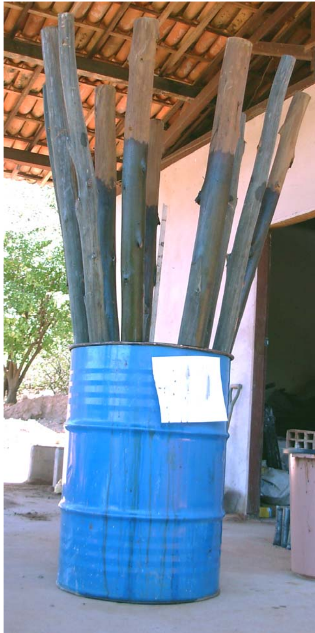
Figura 13 - Peças imersas em tambor com a solução preservativa, em que se verificam as duas situações de tratamento
