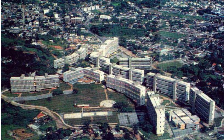
Figura 1: Conjunto Residencial Mirante da Taquara
