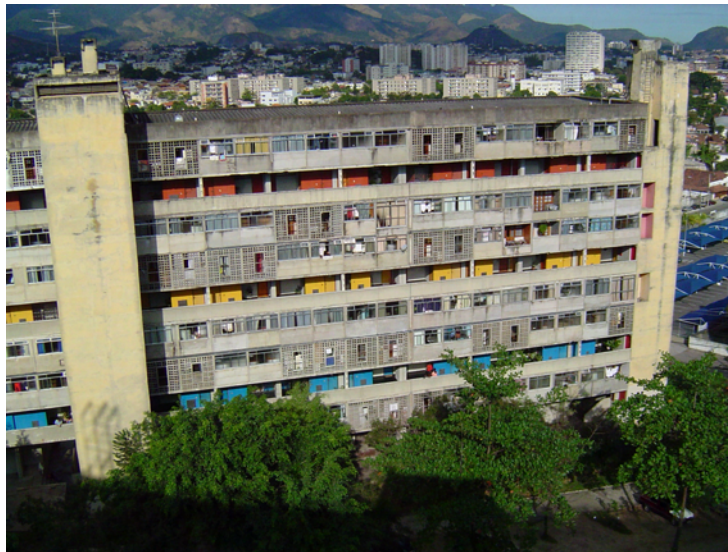
Figura 2: Lateral de Bloco antes da reforma
