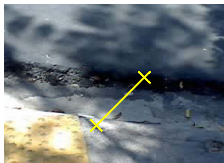
Fig.59 - Desnível da rampa de rebaixamento. Fonte: acervo da autora.
