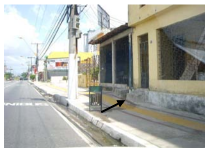
Fig. 46 - Degraus na faixa de acesso. Fonte: acervo da autora.
