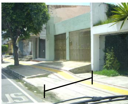
Fig. 49 - Inclinação transversal. Fonte: acervo da autora.
