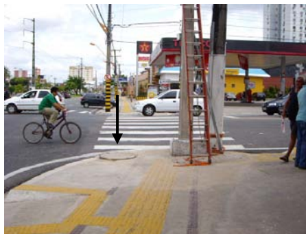
Fig. 44 - Nivelamento da tampa de caixa de inspeção. Fonte: acervo da autora.
