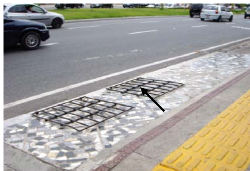
Fig. 52 - Grelhas e juntas de dilatação. Fonte: acervo da autora.
