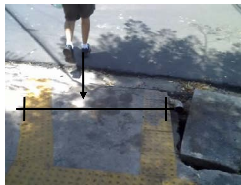
Fig. 58 - Rampa de rebaixamento. Fonte: acervo da autora.
