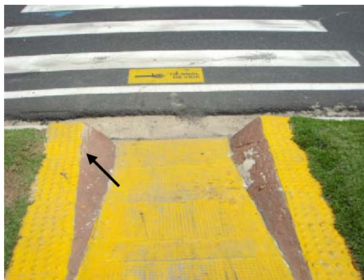
Fig. 56 - Piso tátil em rampa de rebaixamento. Fonte: acervo da autora.
