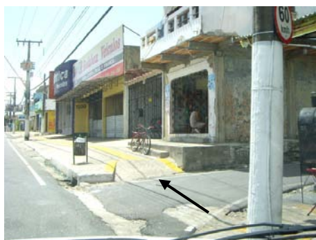
Fig. 60 - Inclinação da rampa de rebaixamento. Fonte: acervo da autora
