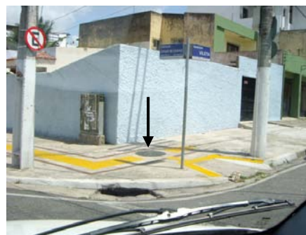
Fig. 42 - Tampa de caixa de inspeção. Fonte: acervo da autora.
