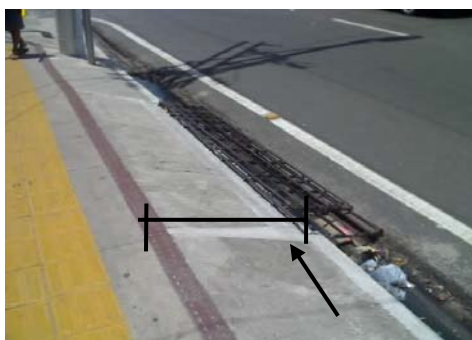
Fig. 43 - Rebaixamento de guias na faixa de serviço. Fonte: acervo da autora.
