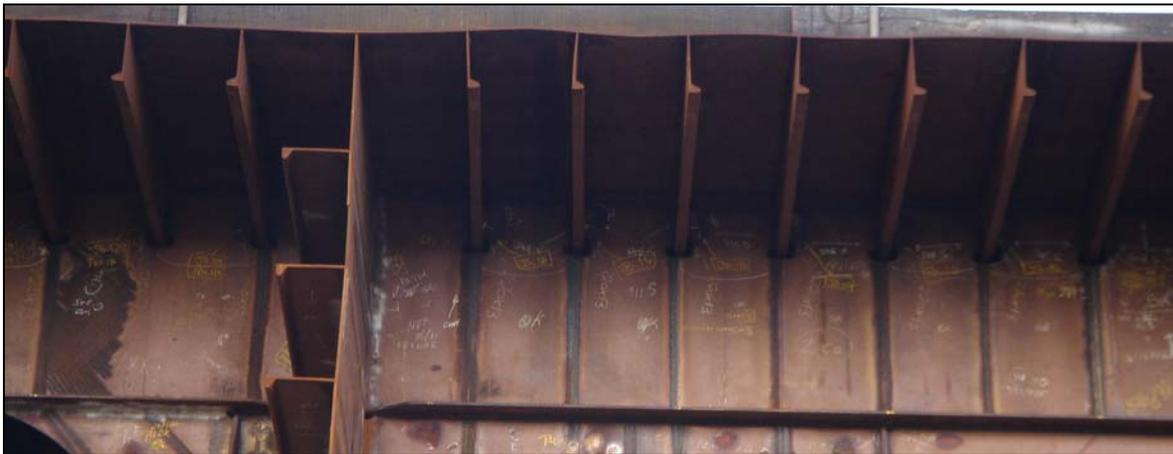
Figura 2.5. Imperfeição geométrica inicial de um painel enrijecido de um bloco de plataforma semi-submersível
