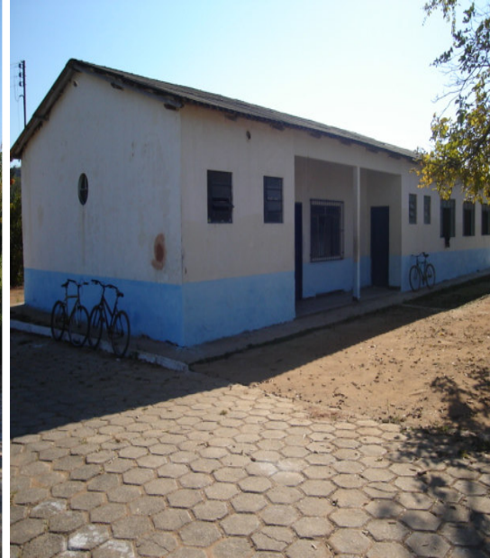
Figura 7. - Instalação de maternidade 1
