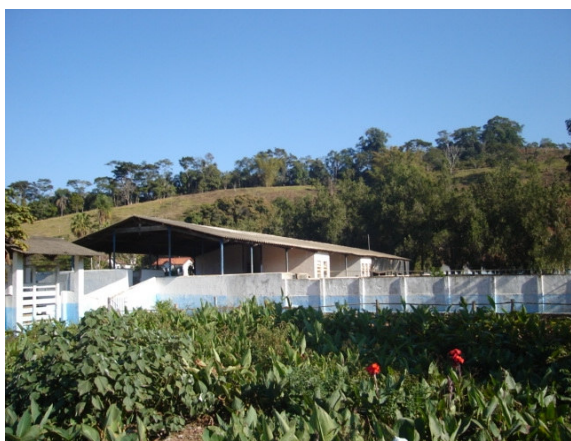
Figuras 24 e 25. – Instalações de crescimento e terminação cujos telhados adicionam águas pluviais aos dejetos
