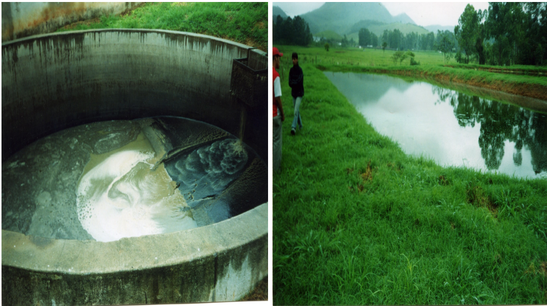
Figuras 17 e 18. – Tanque de decantação e lagoa facultativa do sistema de tratamento de dejetos de suínos - Visita técnica com os alunos na empresa Penalva, no município de Juiz de Fora - outubro/2005
