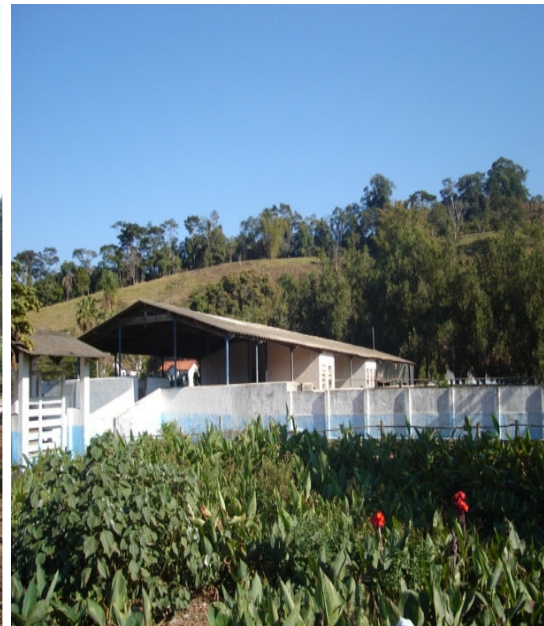
Figura 9. - Instalação de animais em fase de crescimento
