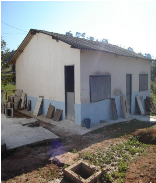
Figura 8. - Instalação de maternidade 2
