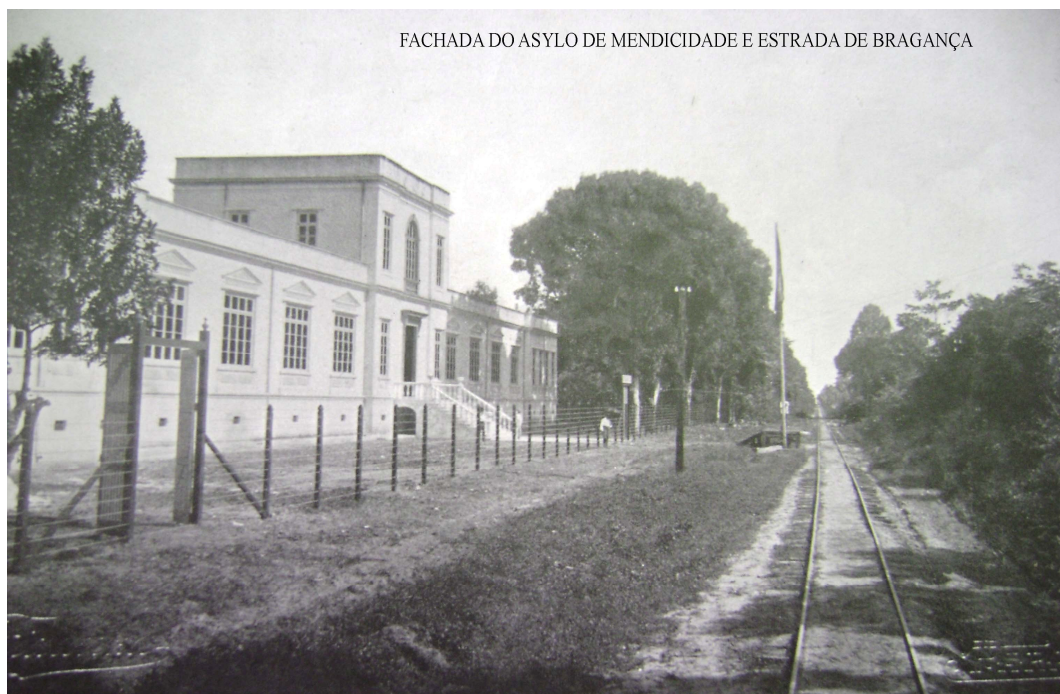
FIGURA 4: Fachada do Asilo de Mendicidade e Estrada de Bragança
