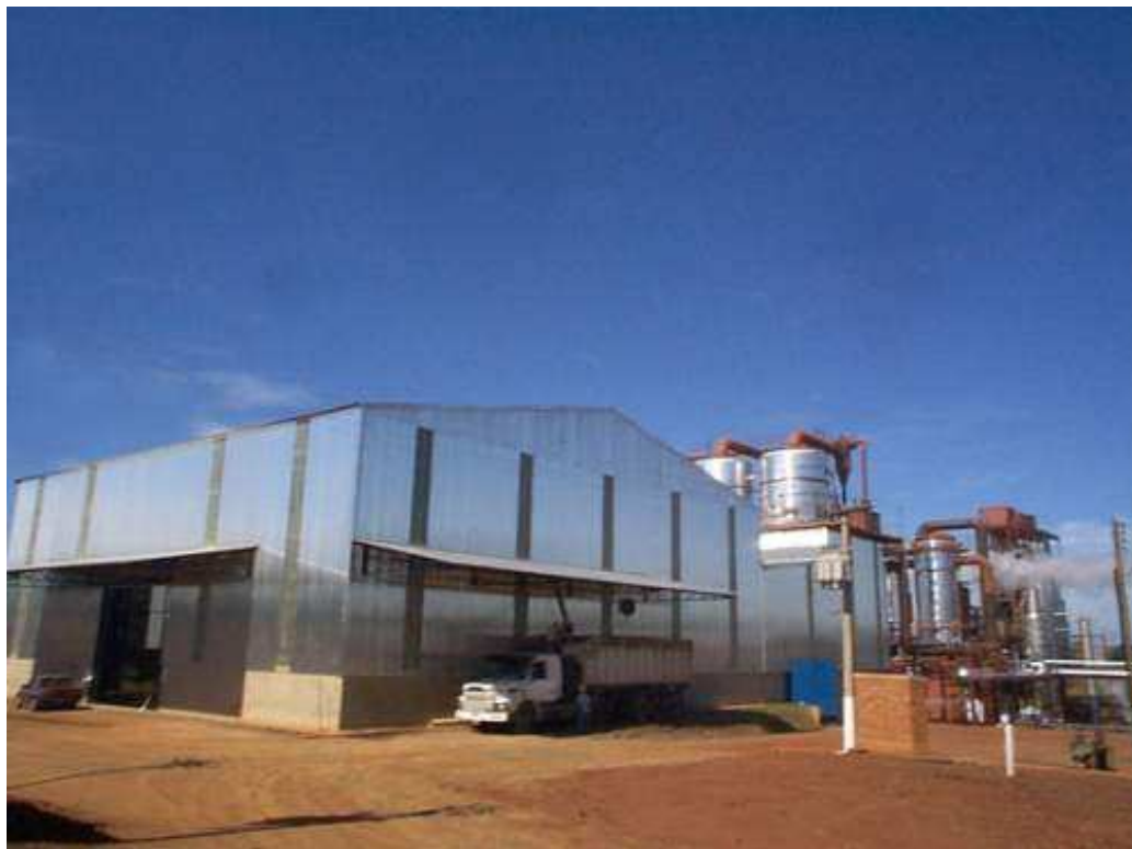
Figura 14: Vista geral da Usina Dela Colleta Fonte: www.coletta.com.br
