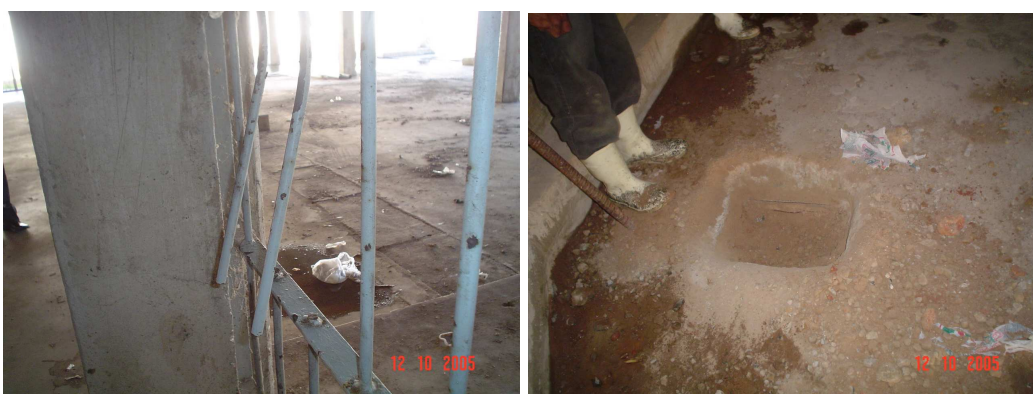
(Foto 01: mais grades cerradas; Foto 02: outro túnel descoberto e começando a ser aberto)
