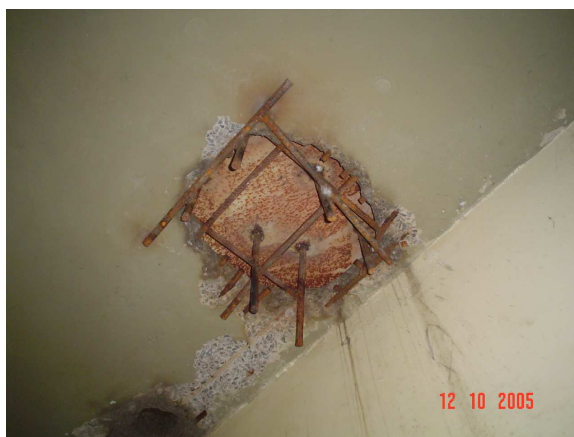
(Foto 01: as grades das celas foram arrancadas e encontram-se amontoadas; Foto 02: buraco no teto sendo tapado com vergalhões improvisados)
