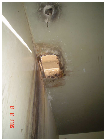
(Fotos 01 e 02: buracos no teto, com visão do pátio e de dentro das galerias)
