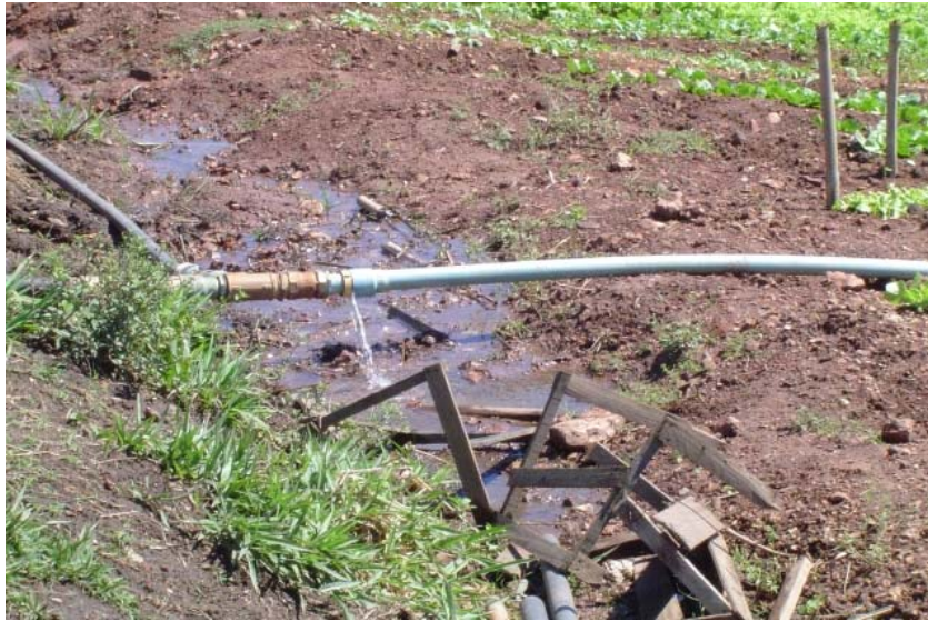
Figura 6 - Vazamento de água em cano de irrigação em propriedade agrícola da BHRM
