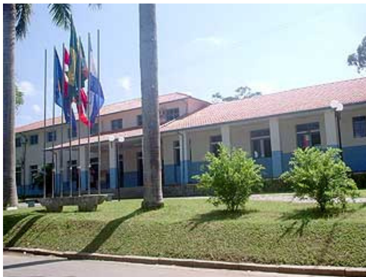
Figura 01 - fachada do Colégio Agrícola de Camboriú - data: 10/01/2008
