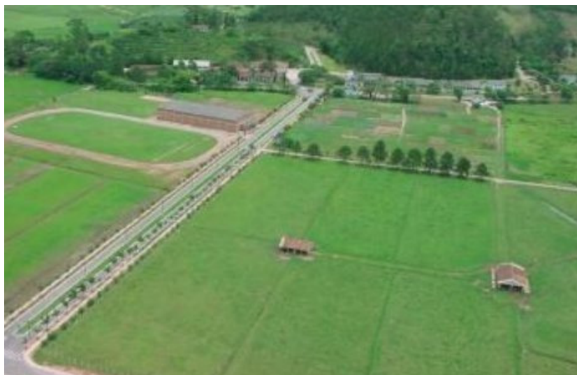
Figura 02 - Vista aérea - parcial - do Colégio Agrícola de Camboriú data: 20/12/2007
