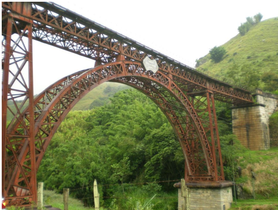
Figura 15 – Ponte sobre o rio Santana
