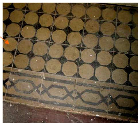
Figura 57 - Imagens do piso de ladrilho hidráulico antes da reforma de 1974. Autor da Fotografia: Foto B- Blásio Junkes Fonte: Acervo Pe. Pedro José Koehler-1974 Acervo autora 2005
