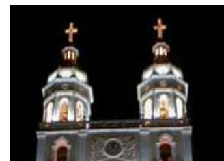
Figura 24 - As torres com iluminação noturna Fotógrafo: Mário Costa Jr. (2003) Fonte: www.Guiafloripa.com.br
