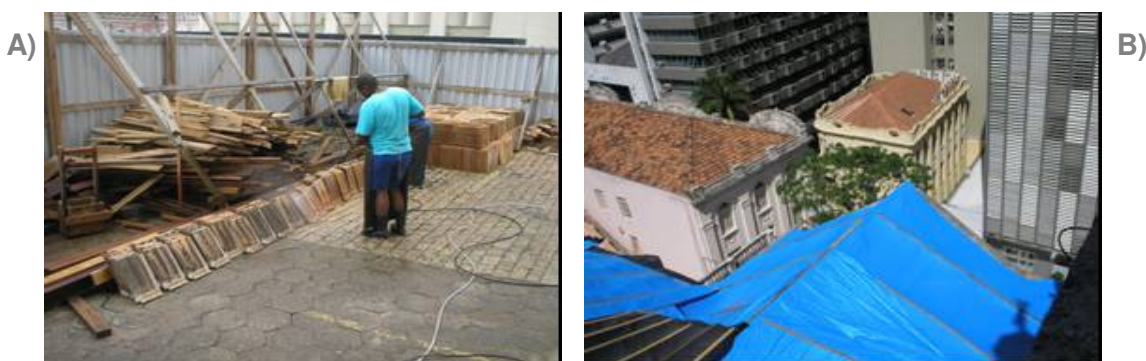
Figura 80 - Imagens das obras na cobertura.
