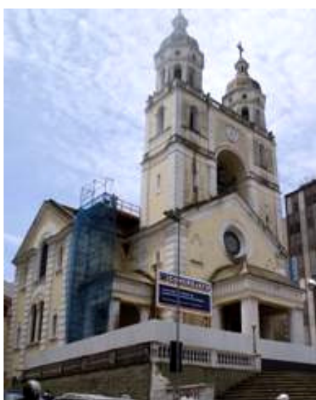
Figura 79 - Conjunto de imagens sobre o início das obras de intervenção (interna e externa) na Catedral: A) colocação dos tapumes isolando a edificação e estruturas de andaimes no entorno da edificação B) colocação dos andaimes e forração do piso, para a consolidação do forro de estuque da nave central. Fonte: Acervo da autora, 2005.
