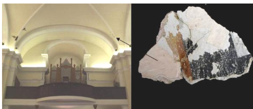
Figura 87- Imagens do fragmento do forro de estuque da nave.
