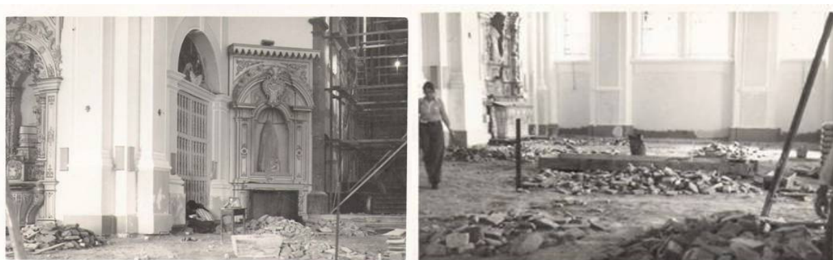
Figura 58 - Imagens da substituição do piso e repintura nas paredes -1974 Autor da Fotografia: Foto B- Blásio Junkes Fonte: Acervo do Pe. Pedro José Koehler-1974
