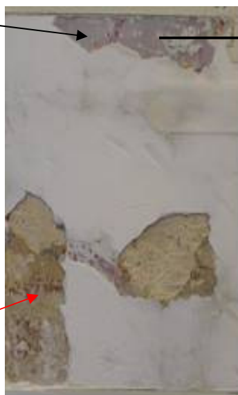
Figura 111 - Prospecções na parede lateral direita da Capela de N. Sr a das Dores. Fonte: Acervo da autora, 2007.
