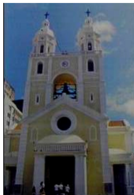
Figura 71 - Catedral após a pintura externa Arquivo FCC- Dir. de Patrimônio-fev/2001
