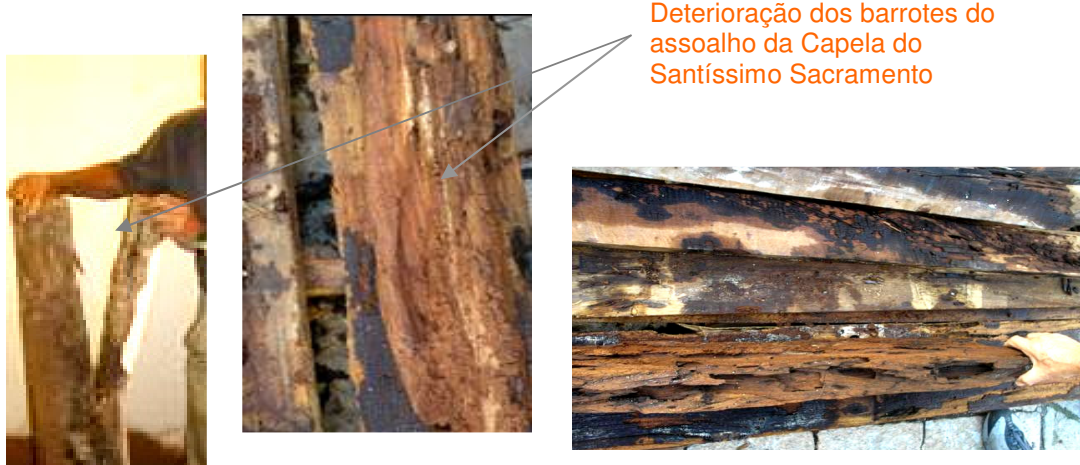
Figura 97 - Imagens da retirada dos caibros e tabuado do assoalho da Capela. Intervenção em decorrência do ataque de insetos xilófagos e da umidade. Fonte: Acervo da autora, 2007.
