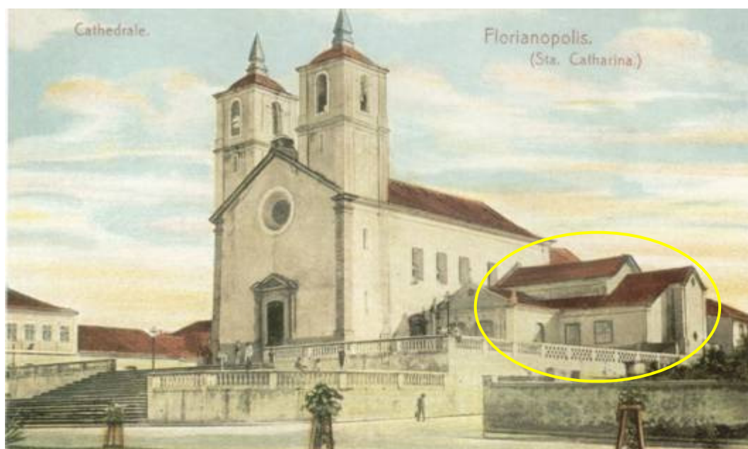
Figura 108- Imagem em cartão postal da Matriz antes da reforma de 1922. Mostra a Capela de N. Sr a . das Dores com as aberturas laterais e a configuração dos fundos da Capela
