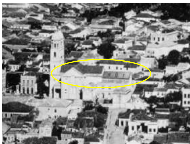
Figura 41 - Configuração da Catedral, anos 30. No detalhe como era a cobertura original da Matriz com telhas novas e antigas.
