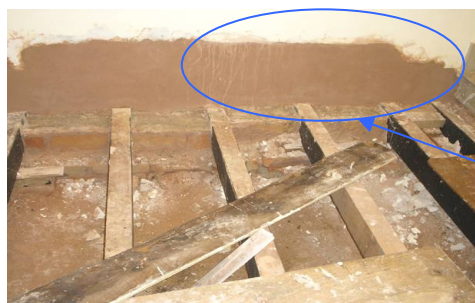
Figura 98- Imagens da substituição dos caibros. No detalhe esquerdo calço de cimento. No detalhe direito substituição do reboco. Fonte: Acervo da autora- 2007
