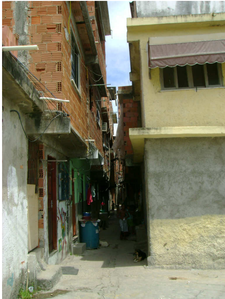
Foto 10: Verticalização e expansão das habitações em becos
