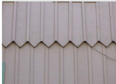
Figura 3.2 Detalhe da parede de tábua e mata-juntas. Casa Erbo Stenzel, parque São Lourenço, Curitiba-PR. Foto do autor, 2005
