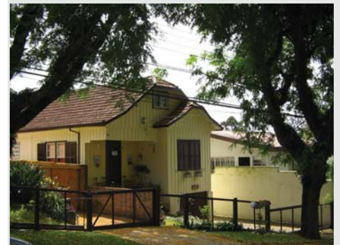
Figura 1.20 Casa Rua Pe. Francisco Aulling, em Curitiba-PR. Foto do autor, 2006.
