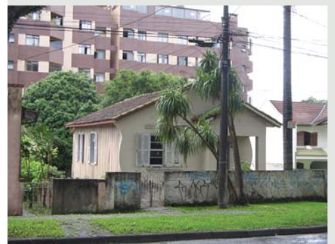
Figura 3.48 Casa mista tipo chalé com frente em alvenaria e restante em tábuas e mata-juntas. Rua Guaratuba em Curitiba-PR. Foto do autor, 2007.
