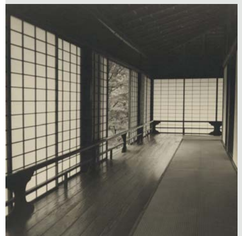
Figura 4.14 Imagem interna do do Palácio Imperial de Katsura-Japão, datado de 1620. Detalhe dos painéis “Shoji” e o “tatami”. Site www.library.osu.edu . Acesso em 27 de abril de 2007.
