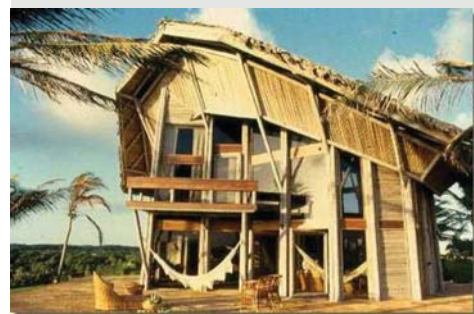
Figura 6.8 Casa na Ilha dos Poldros, no Maranhão. Projeto de Gerson Castelo Branco, na década de 90. Site: www.gersoncastelobranco.com.br . Acesso em 07 de maio de 2007.
