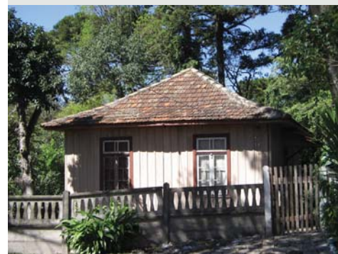
Figura 1.7 Casa Travessa Armando Mann, Curitiba-PR. Foto do autor, 2007.
