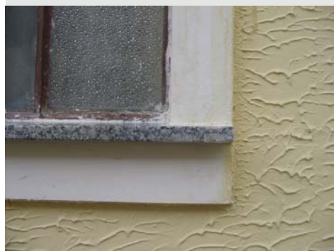
Figura 3.111 Detalhe da textura característica das casas revestidas com placas de Erkulit. Foto do autor, 2006.
