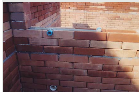
Figura 4.16 Parede com blocos de solo estabilizado. Site www.construcaoeconomica.tripod.com.br . Acesso em 27 de abril de 2007.
