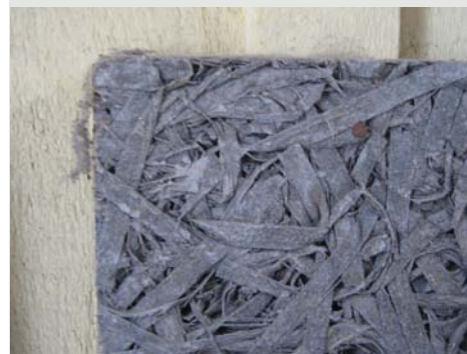
Figura 3.106 Detalhe da placa de Erkulit. Foto do autor, 2006.
