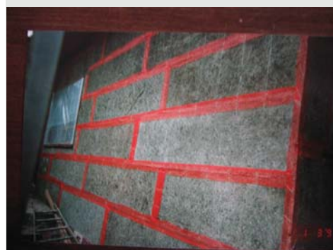
Figura 3.110 Detalhe de aplicação da tela plástica sobre as placas de Erkulit. Fonte: Acervo empresa Erkulit Ind. e Com. LTDA, sem data.
