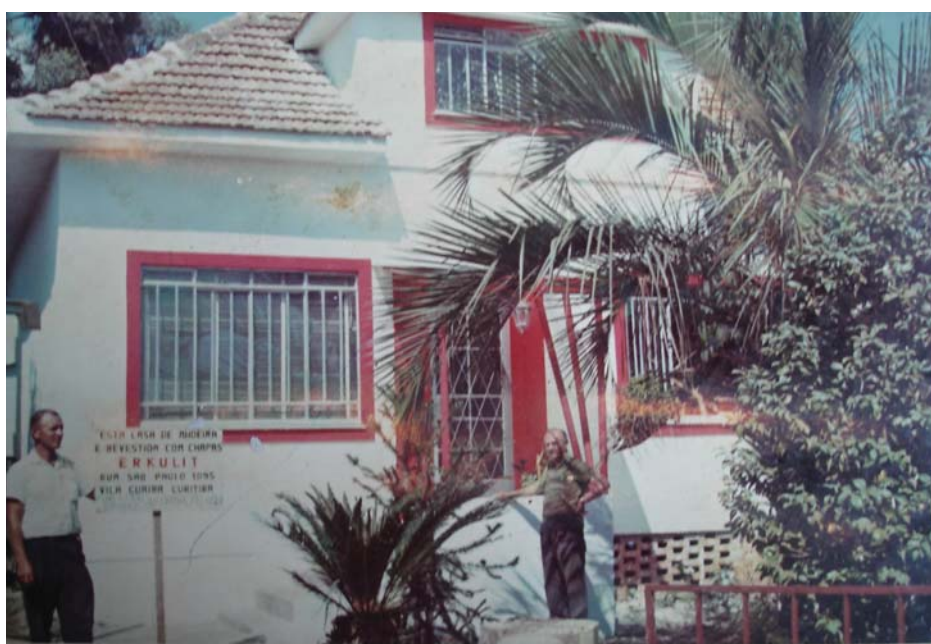
Figura 3.119 Casa revestida com placas de Erkulit. Fonte: Acervo empresa Erkulit Ind. e Com. LTDA, 1972.
