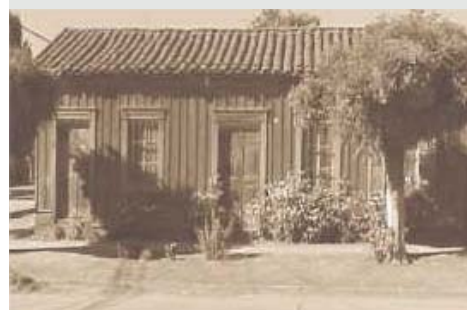
Figura 3.6 Casa Cruses datada de 1895 em Puren, Chile Fonte: site www.municipalidadpuren.blogspot.com . Acesso em 22 de abril de 2007.
