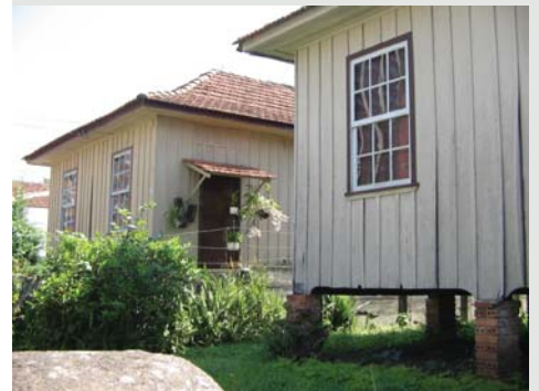
Figura 4.39 Detalhe do acabamento do encontro da tábuca com o pilarete de embasamento. Conjunto de casas Rua Pe. Anchieta. Foto do autor, 2006.
