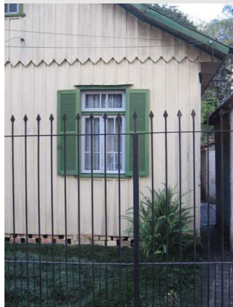
Figura 3.88 Detalhe da janela em 02 folhas. Casa Rua Francisco Alves Guimarães em Curitiba-PR. Foto do autor, 2006.
