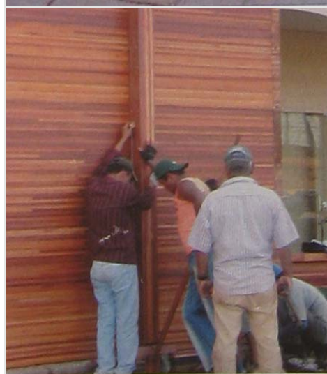
Figura 6.67 e Figura 6.68 Detalhe do painel e foto da montagem. Fonte: Revista Arquitetura e Construção, novembro de 2005.
