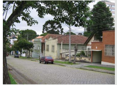
Figura 3.19 Casa de madeira com frente em alvenaria nas imediações da área central em Curitiba-PR (Rua Celestino JR.) Foto do autor, 2006.
