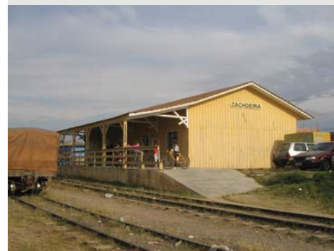
Figura 5.7 Estação Cachoeira em Madeira. Almirante Tamandaré-PR. Foto do autor, 2006.
