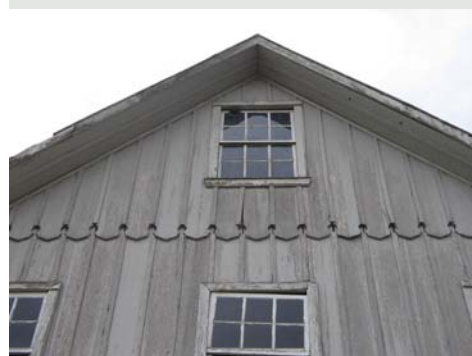
Figura 3.90 Detalhe do oitão. Casa em Rio Claro do Sul-PR. Foto do autor, 2006.
