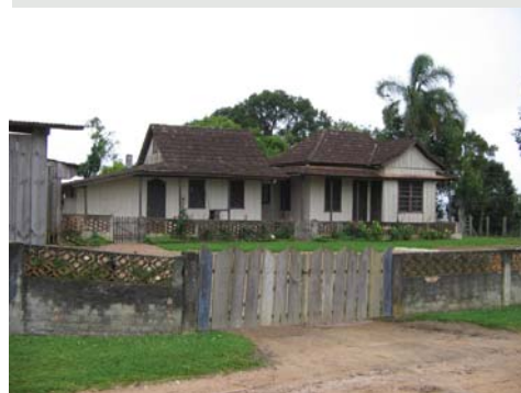
Figura 1.34 Casa Colônia Muricy em São José dos Pinhais-PR. Foto do autor, 2006.
