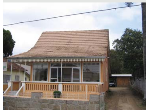
Figura 2.10 Detalhe das janelas substituída por panos de vidro. Casa Rua Manoel Ribas em Curitiba-PR. Foto do autor, 2006.
