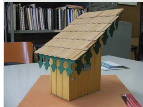
Figura 3.11 Maquete de detalhe construtivo de telhado com lambrequins. Fonte: Curso de Arquitetura e Urbanismo da UFPR. Cadeira de Arquitetura Brasileira - Professor Key Imaguire Jr.
