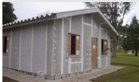
Figura 4.20 Casa construída com painéis de chapa cimentícia. Site www.eternit.com.br . Acesso em 27 de abril de 2007.
