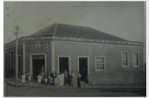
Construção mista. Paredes externas de alvenaria e internas de madeira. Propriedade da família Domingos no Norte Velho do Paraná.
