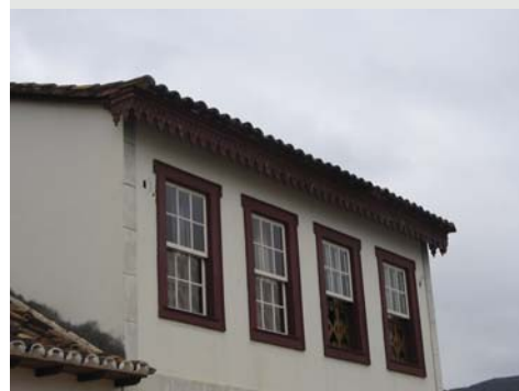
Figura 3.33 Casa em Tiradentes-MG, datada provavelmente do início do século XX. Presença de lambrequins influenciado pelo ecletismo francês Foto do autor, 2006.
