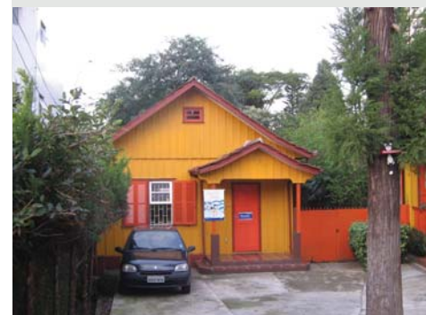
Figura 1.26 Casa Rua Ubaldino do Amaral, em Curitiba-PR. Foto do autor, 2006.
