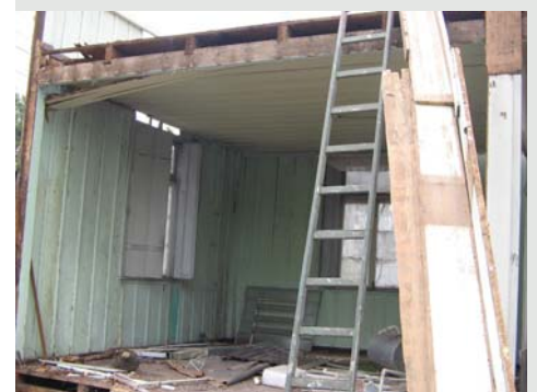
Figura 3.69 Detalhe das peças de uma Casa de Araucária do início do século XX sendo demolida. Rua Trajano Reis em Curitiba-PR. Foto do autor, 2007.
