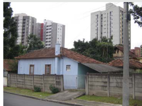
Figura 3.97 Detalhe da ampliação do banheiro em alvenaria. Casa no bairro do Portão em Curitiba-PR. Foto do autor, 2006.
