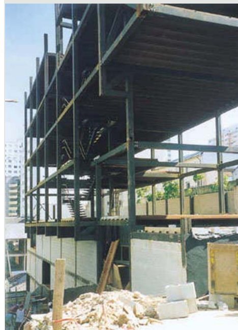
Figura 4.18 Edifício sendo construído com estrutura em aço. Site www.arcoweb.com.br . Acesso em 27 de abril de 2007.
