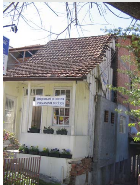
Figura 1.10 Casa de madeira sendo gradativamente substituída por alvenaria. Rua Jacarezinho, Curitiba-PR. Foto do autor, 2006. Na finalização do trabalho a casa de madeira encontra-se totalmente demolida.
