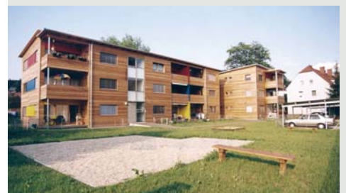
Figura 7.19 Habitação coletiva em madeira. site www.holzbau-kaernten.at/ Acesso em 11 de maio de 2007.
