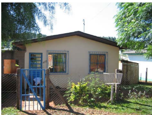
Figura 4.266: Fachada de UH em NHSL.
