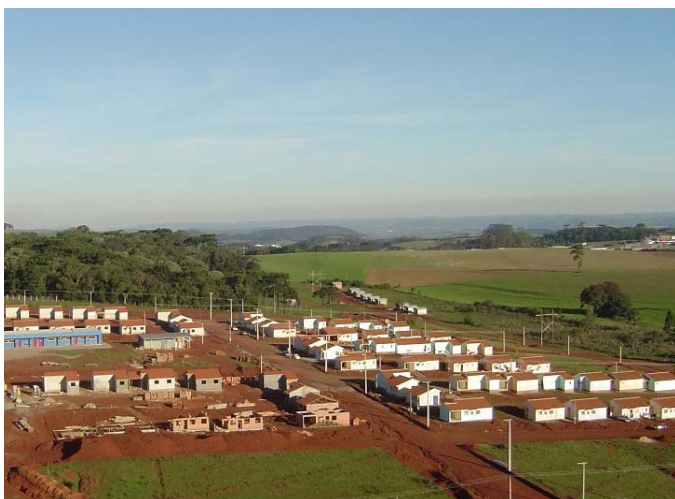
Figura 4.8: Vista do Lot. Frei Adelar, em construção. Fonte: foto cedida por Fernando Lodi, tirada em 26/05/2005.
