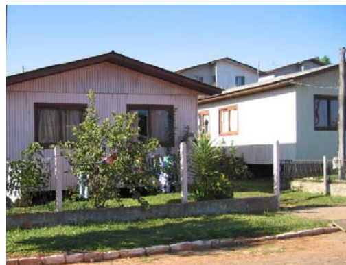
Figura 5.4: janelas com cortinas nas habitações do NH Morar Bem.
