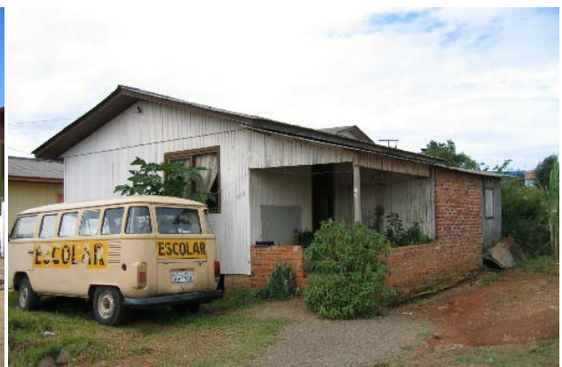
Figura 4.222: Fachada de UH em NHMB.
