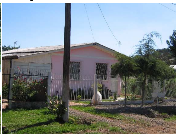
Figura 4.277: Fachada de UH em NHSL.
