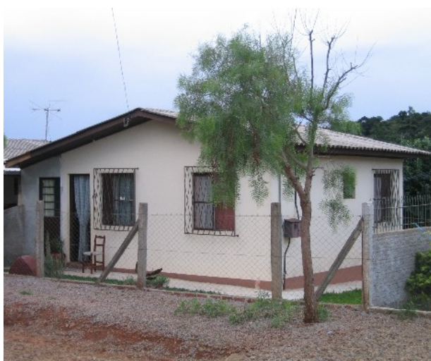
Figura 4.24: Fachada de UH em NHSL.
