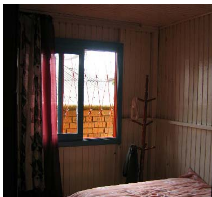
Figura 5.3: Janela com cortinas escuras na UH MB H1 06.
