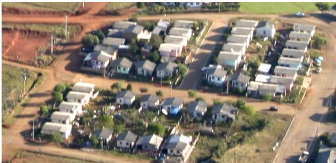
Figura 4.13: Vista aérea dos 3 Núcleos em estudo. Fonte: PMM/RS, 2004.
