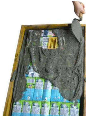
Figura 22: Aplicação da segunda camada de argamassa.
