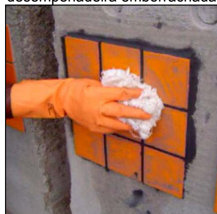
f) limpeza final da cerâmica com estopa limpa e seca.
