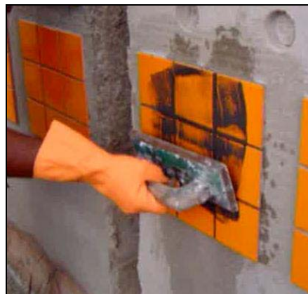
d) aplicação do rejunte com desempenadeira emborrachada.
