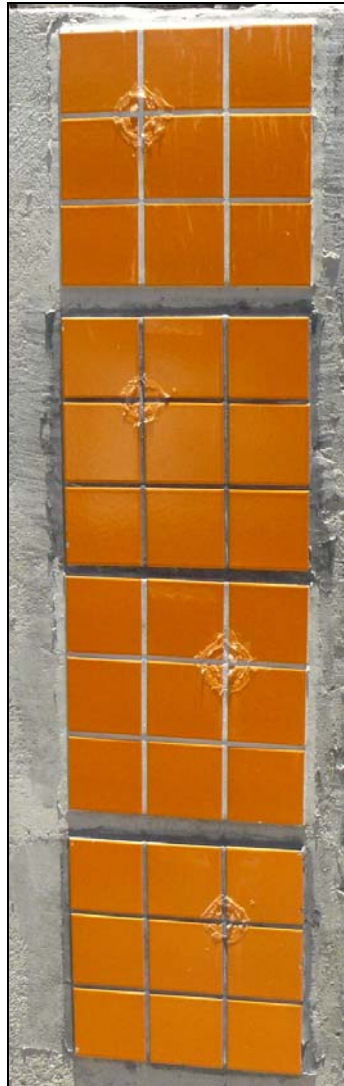
Figura 5.22 – Vista dos 4 painéis executados ao ar livre.
