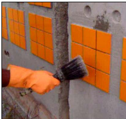
c) umedificação das juntas.
