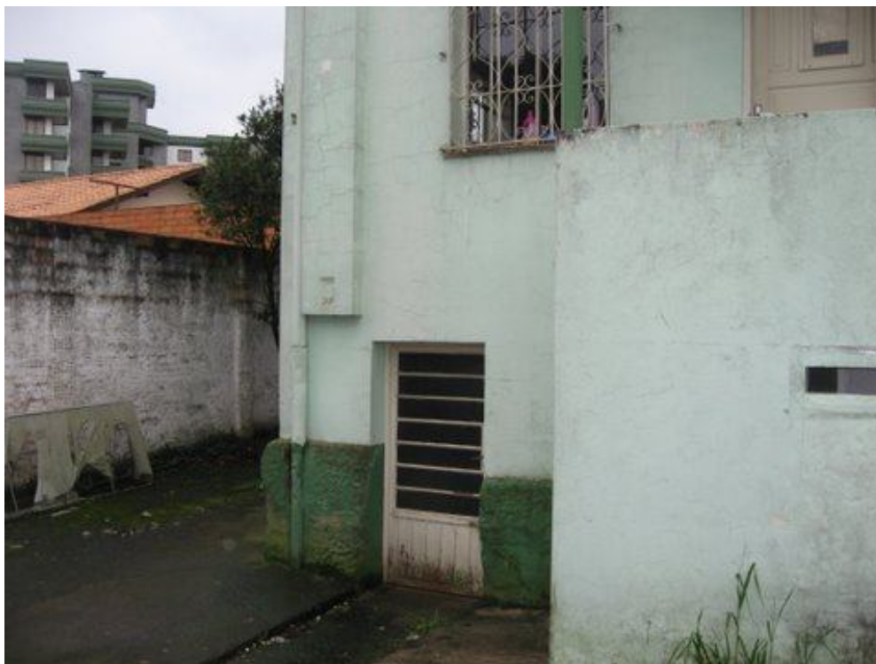
Figura 10 - Casa 10, fundos, com porão, local de moradia de cães e gatos.
