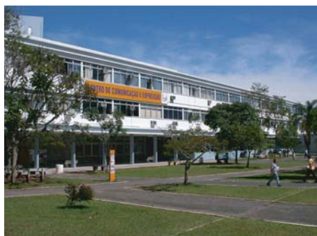
Figura 3-02. Centro de Comunicação e Expressão.
