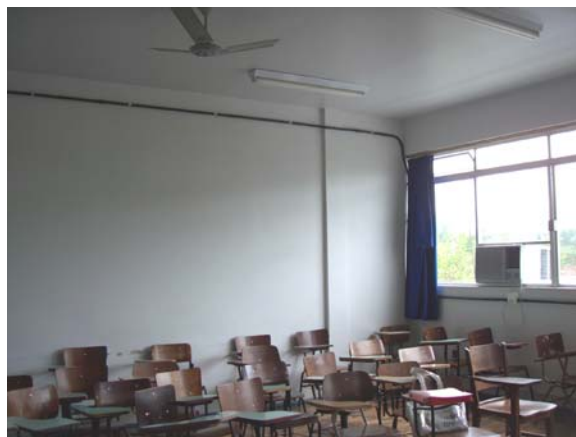
Figura 3-07. Sala 248 e janela horizontal.
