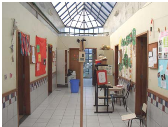
Figura 3-08. Iluminação zenital no corredor.
