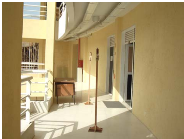
Figura 3-22. Pontos Ev1 e Ev2 no corredor.
