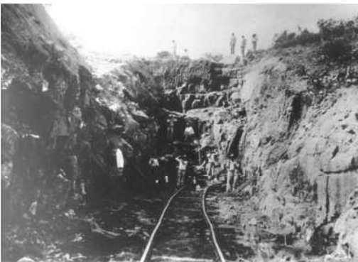
Figura 38 – Construção da ferrovia, Laguna. Fonte: Arquivo Histórico Municipal.
