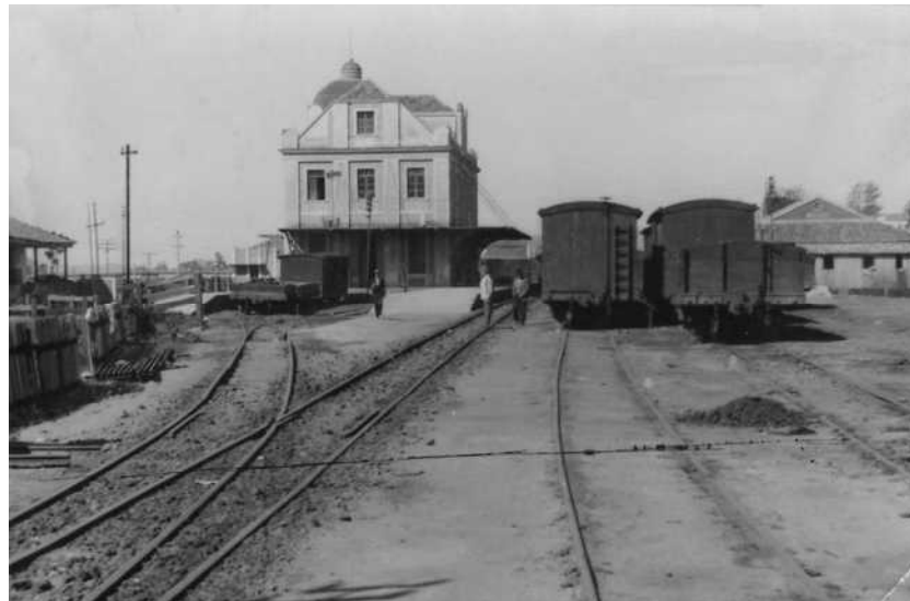
Figura 65 - Vista parcial da Estação Piedade – 1940. Fonte: Arquivo Histórico Municipal.
