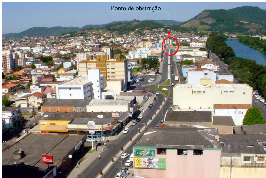
Figura 125 – Vista da Avenida. Nos fundos seu prolongamento obstruído. Fonte: Prefeitura Municipal de Tubarão.
