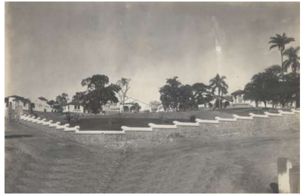
Figura 68 - Vila dos Engenheiros concluída. Fonte: Arquivo Histórico Municipal.
