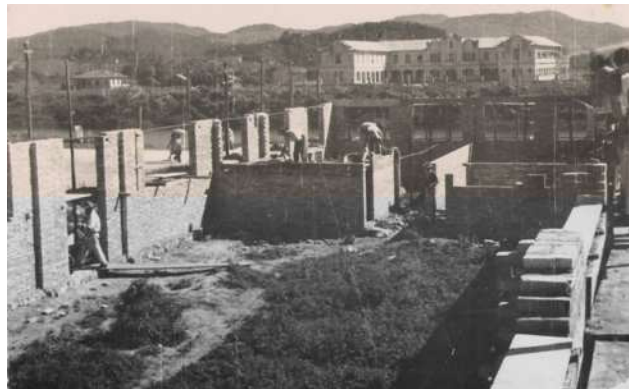
Figura 72 – Construção Escola dos Ferroviários. Fonte: Arquivo Histórico Municipal.
