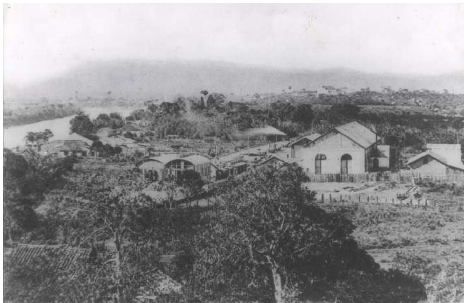
Figura 45 – Vista da Oficina Central em instalação, 1906. Fonte: Arquivo Histórico Municipal.
