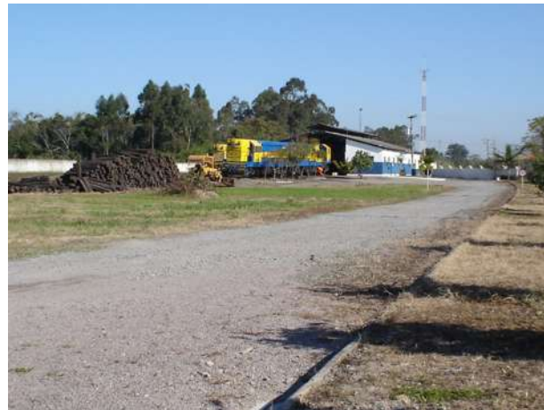
Figura 81 - Estação Tubarão, serviços de manutenção. Fonte: Acervo Rodrigo Althoff Medeiros.
