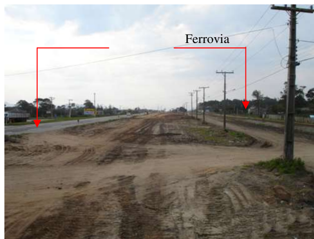
Figura 127 – Obras de duplicação da BR 101 ao lado do leito da ferrovia. Fonte: Acervo Rodrigo Althoff Medeiros.
