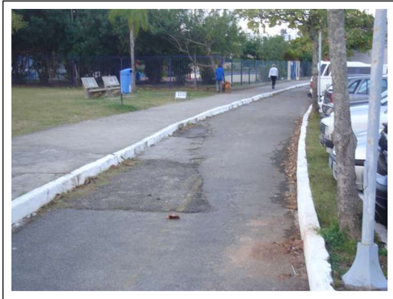
Figura 37: Condição de asfalto na ciclovia Beira-Mar Norte (acervo do autor)
