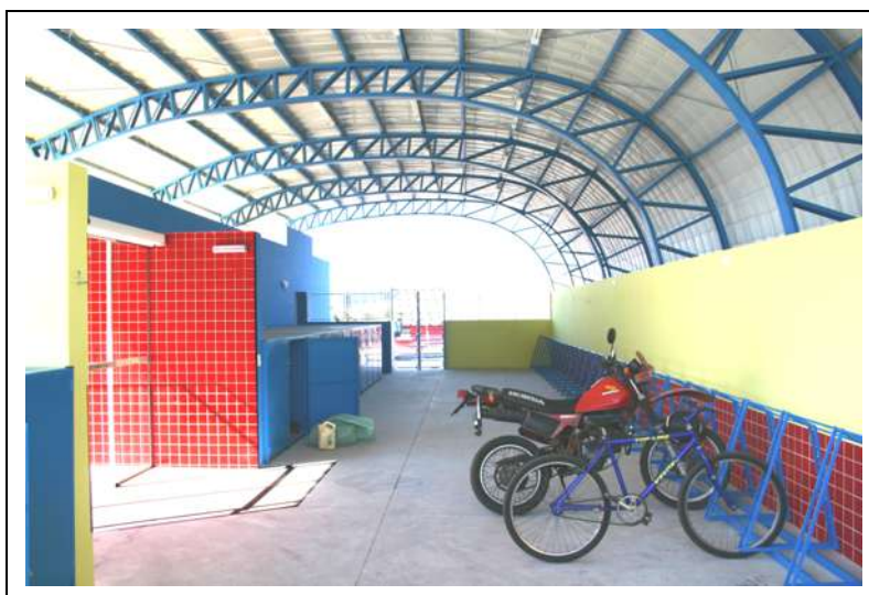
Figura 42: A forma de construção do modelo para o bicicletário tem um telhado de vão livre em estrutura metálica treliçada (acervo do autor)
