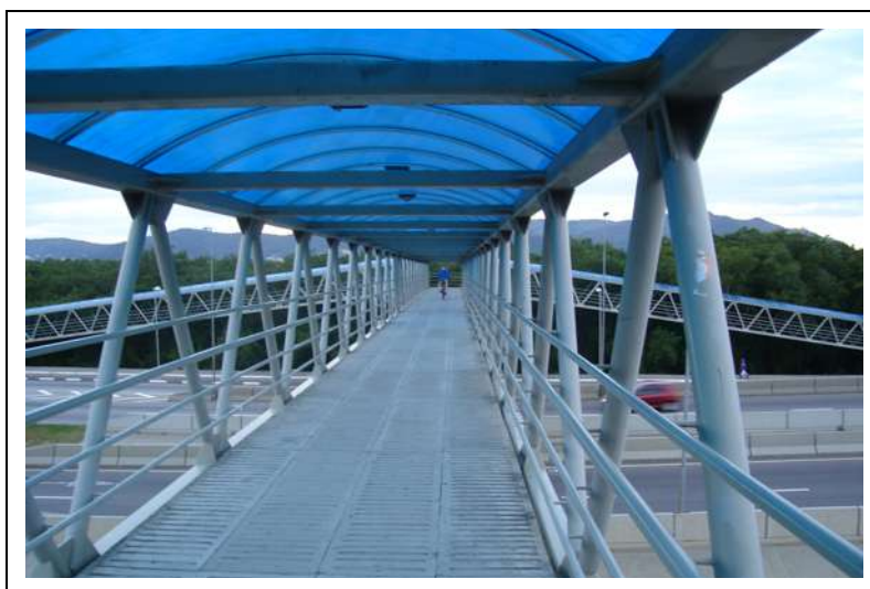
Figura 43: As passarelas são estruturas metálicas tubulares treliçadas (acervo do autor)
