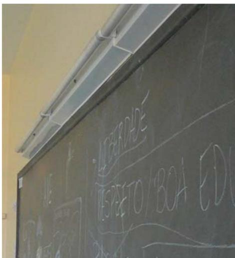
Figura 3.13 – Luminárias existentes localizadas para quadro negro.
