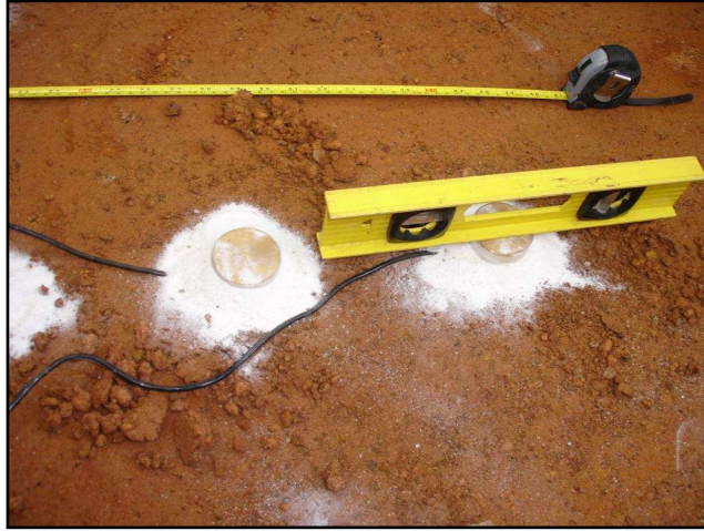
Figura 4.60: Instalação das células de carga a 30,0 cm entre si (entre as camadas de sub-base e base do pavimento estudado).
