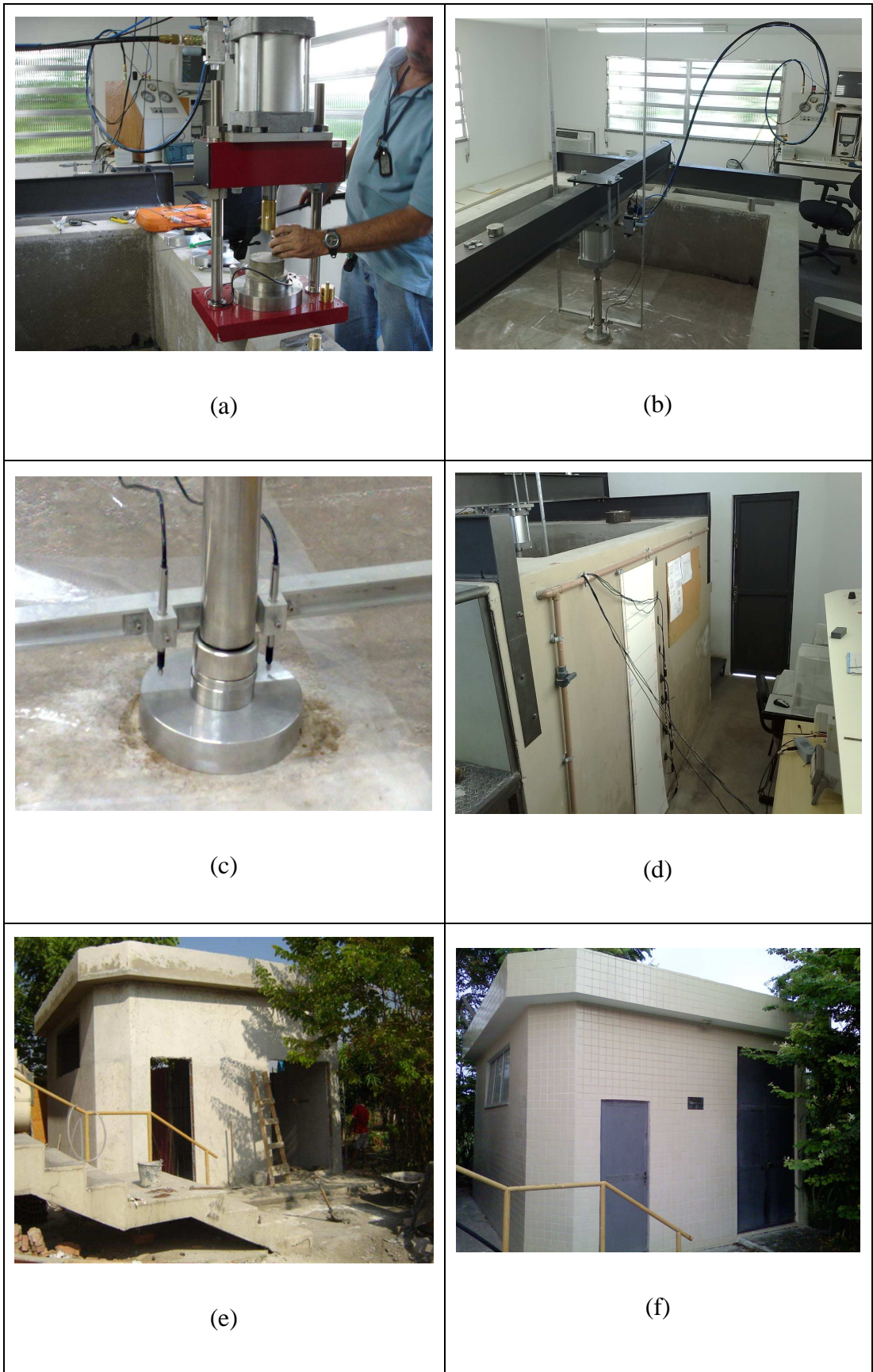
Figura 4.5: Detalhes do tanque-teste e da sala onde o mesmo se encontra.
