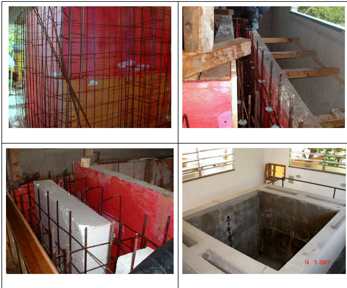
Figura 4.3: Etapas da construção do tanque-teste.
