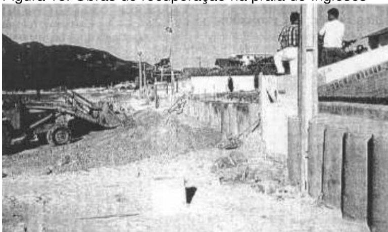
Figura 18. Obras de recuperação na praia de Ingleses
