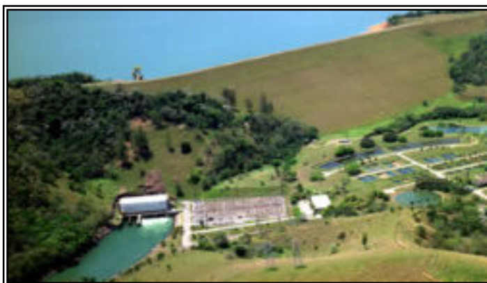
Usina Hidrelétrica Paraibuna – São Paulo
