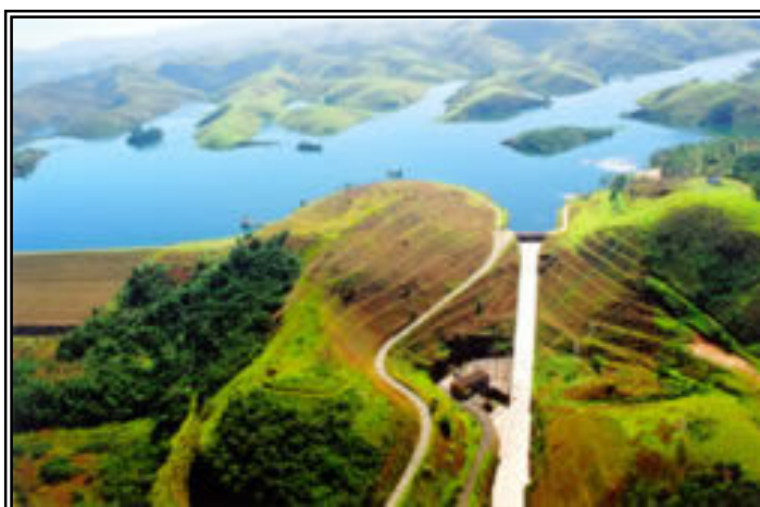
Usina Hidrelétrica Jaguari – São Paulo
