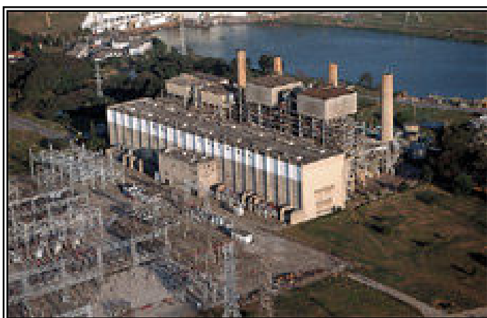
Usina Hidrelétrica Piratininga – Matriz da CESP – São Paulo
