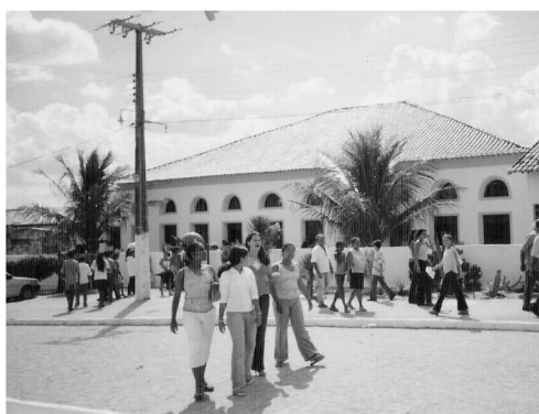
Foto n. 07 – Casa de Caridade do Pe. Ibiapina, reformada, em Santa Fé – PB.
