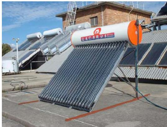
Figura 2.1 Coletor solar de tubos evacuados. Fonte: Morrison (2006).
