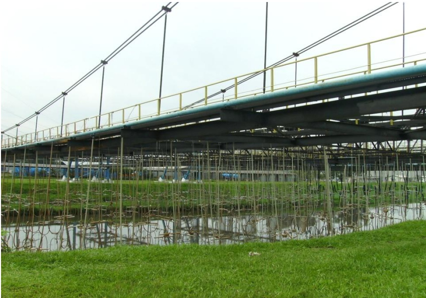
Figura 9: Estação de Flotação Pedreira
