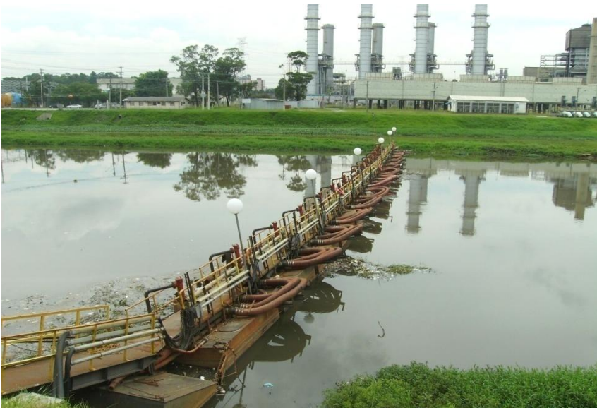
Figura 10: Sistema de retirada do lodo – EF Pedreira
