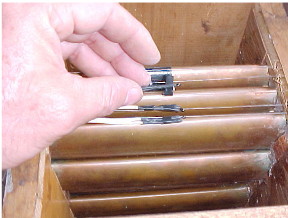
Figura 25 - Instalação dos termistores na entrada do arranjo
