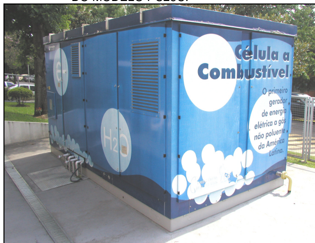
FIGURA 02- CÉLULA A COMBUSTÍVEL ESTACIONÁRIA DO MODELO PC25C.
