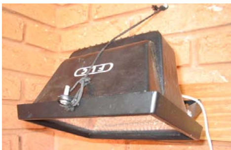
Figura 3.12: Refletor de 500W marca FLC.
