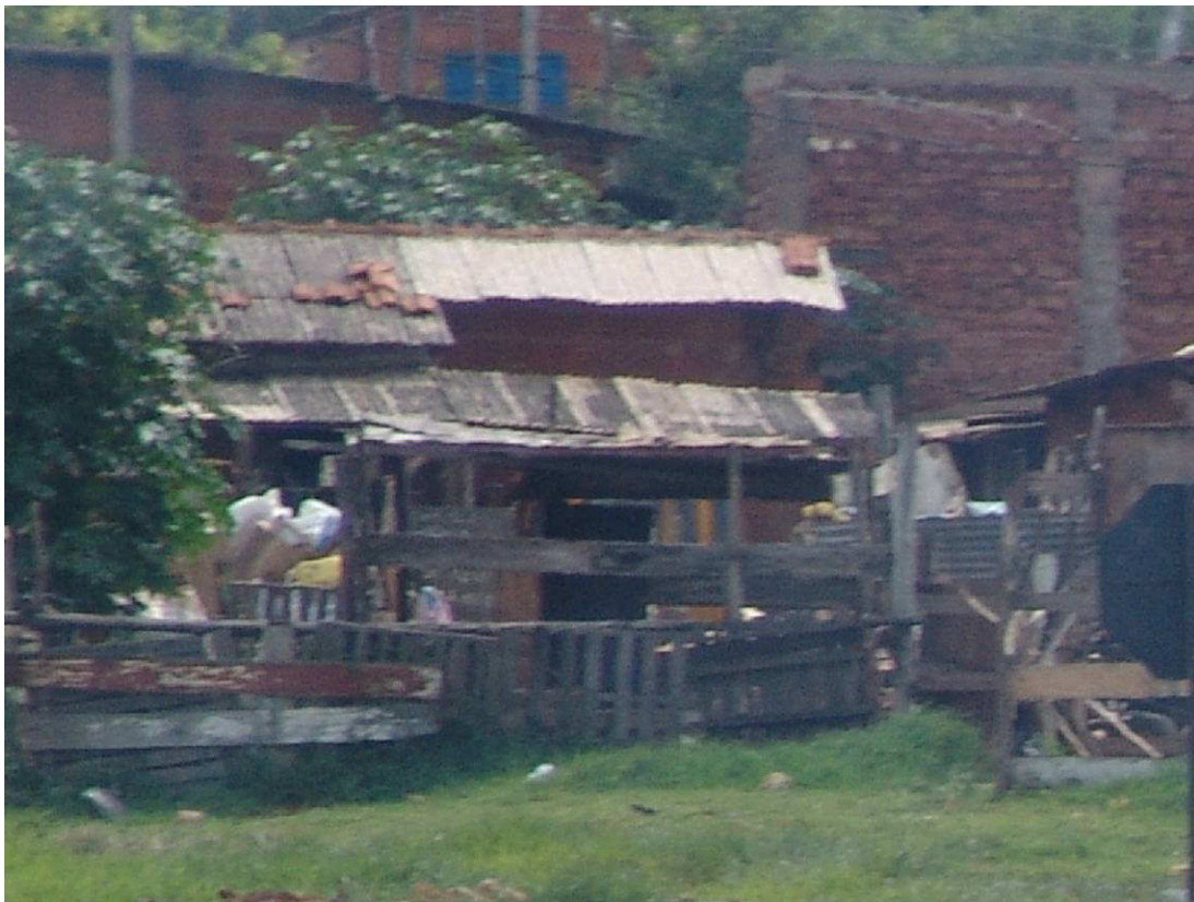
Figura 7 – Tipo de residência presente no Núcleo Fortunato Rocha Lima.
