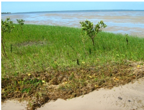
FIGURA 38 – EROSÃO ATINGINDO A ÁREA DO EXPERIMENTO (10ª COLETA).
