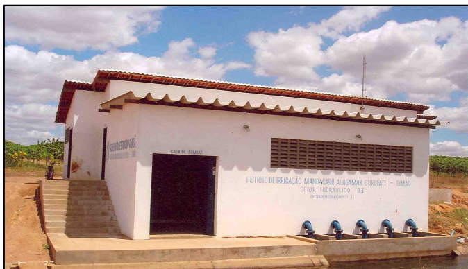
Foto 23 – Estação de Bombeamento do Projeto de Irrigação do Curupati
