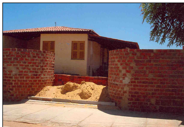
Foto 10 – Edificação residencial em reforma.
