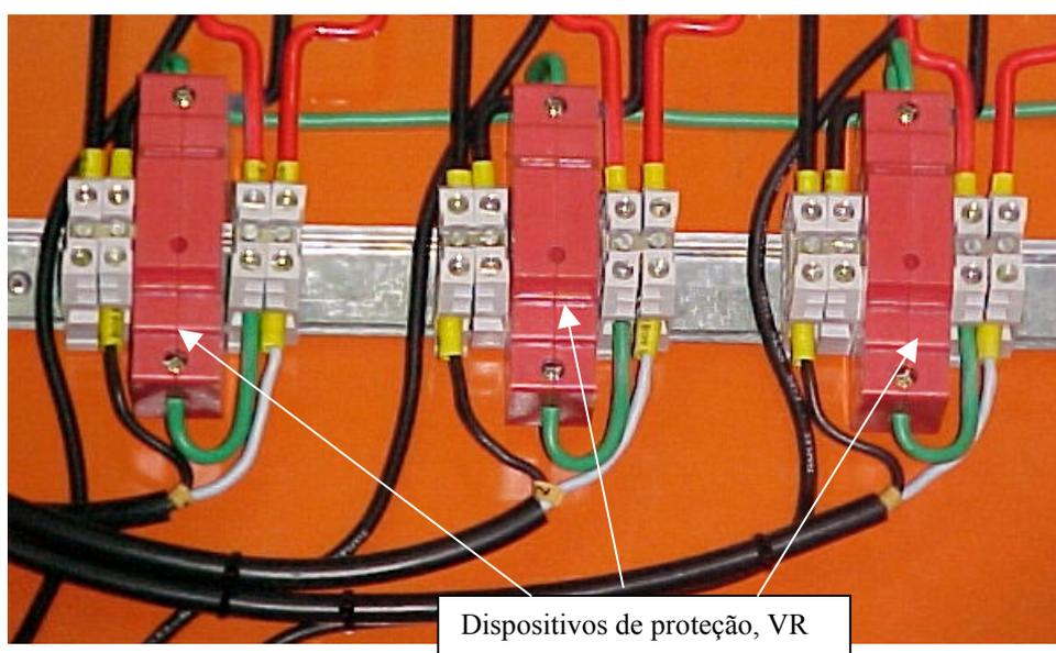
**Figura 4.4** Dispositivos de proteção contra sobre-tensões transitórias.
