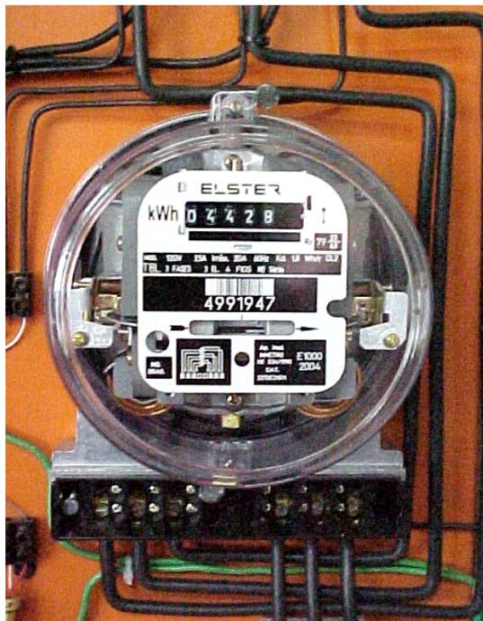
**Figura 4.6** Medidor de energia Med 1 (watt-horímetro).
