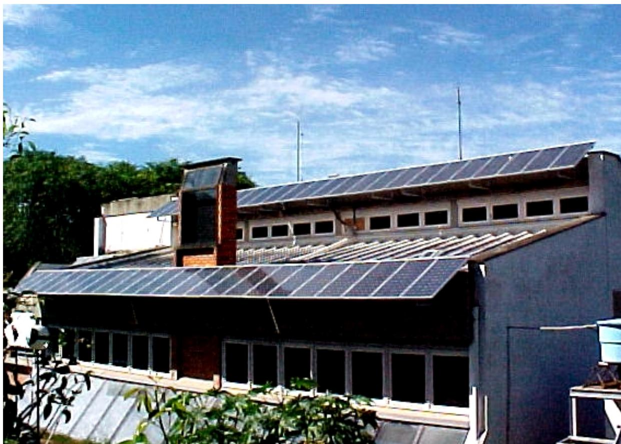
**Figura 3.1** Prédio do Laboratório de Energia Solar da UFRGS com os módulos instalados.
