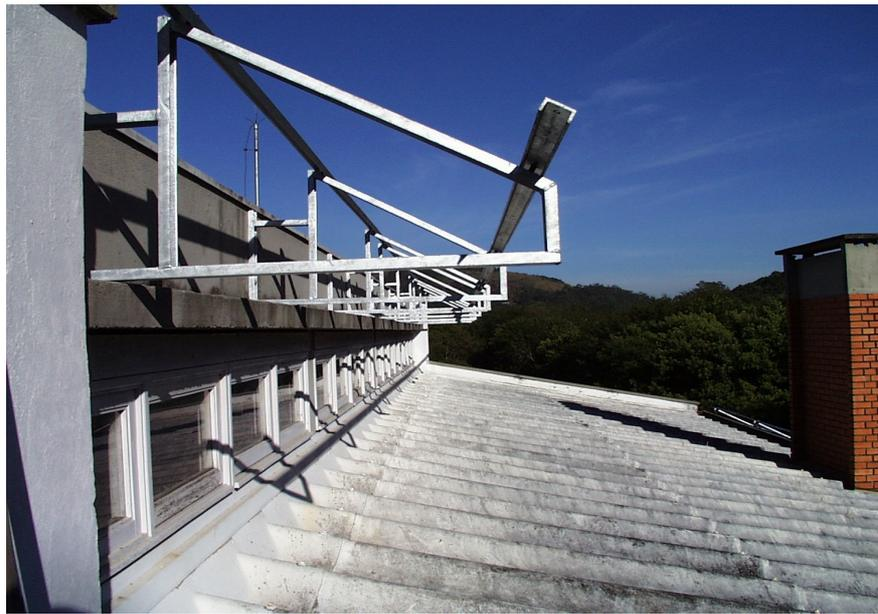
**Figura 4.7** Estrutura da instalação dos módulos na parte superior do Laboratório de Energia Solar.
