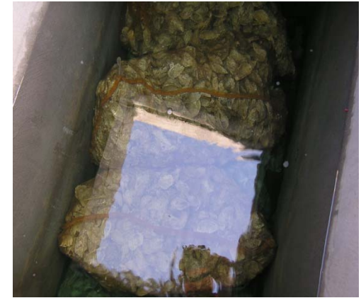
Figura 11. Biofiltro do sistema de recirculação
