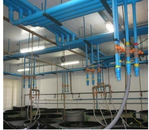
Figura 10. Distribuição de água do Sistema de recirculação
