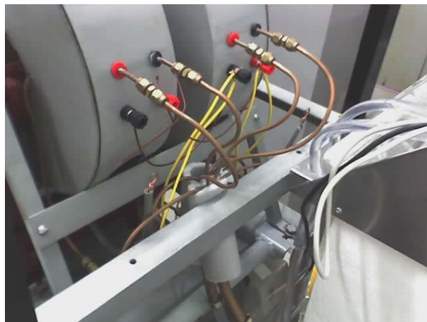
Figura 1.27 – Conexões do circuito de arrefecimento ligado no sistema.
