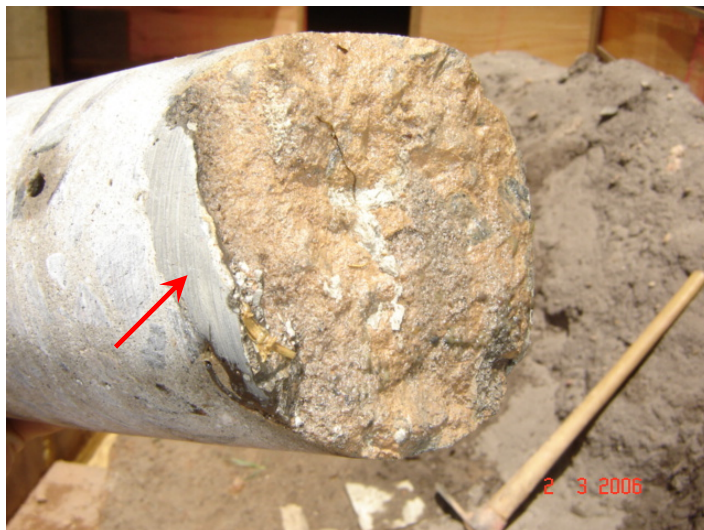
Figura 5.27 – Face interna da trinca impregnada com areia e argila.
