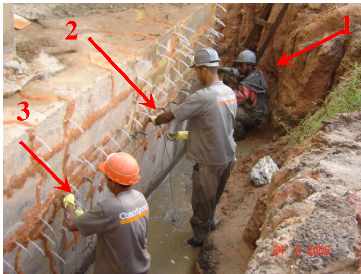
Figura 5.52 – Pontos de saída do microcimento pelos purgadores.
