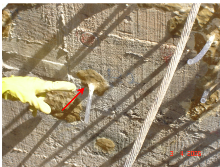
Figura 5.48 – Colmatação do furo de 2” com argamassa de epóxi.
