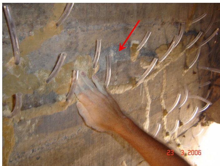
Figura 5.37 – Aplicação da argamassa de epóxi e caulim sobre a trinca grauteada.
