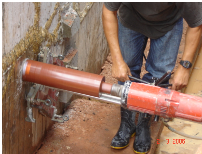
Figura 5.22 – Retirada de testemunho para análise laboratorial.
