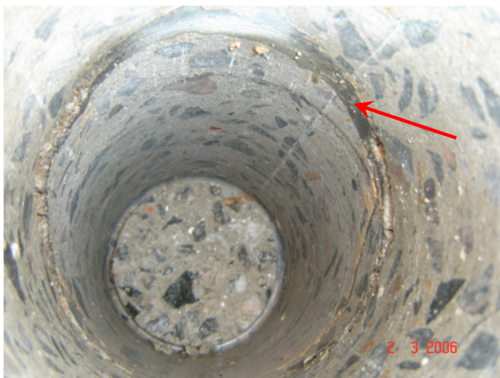
Figura 5.28 – Comportamento da trinca no interior do bloco, vista pelo furo realizado na extração de testemunho.
