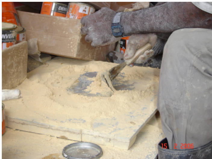
Figura 5.35 – Preparo da argamassa de epóxi e caulim.
