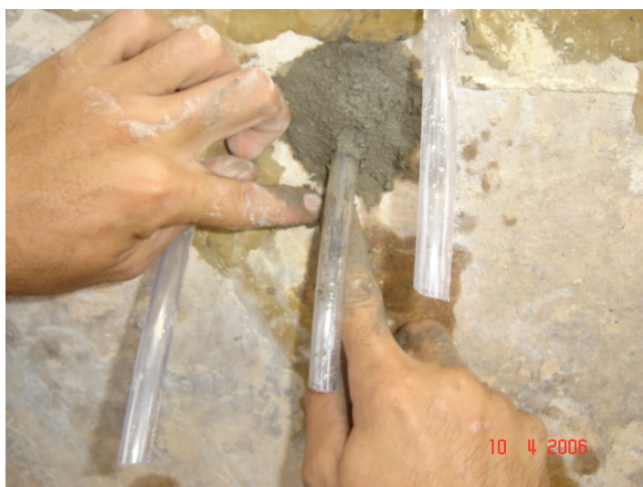
Figura 5.47 – Fechamento do furo de 2” com graute.
