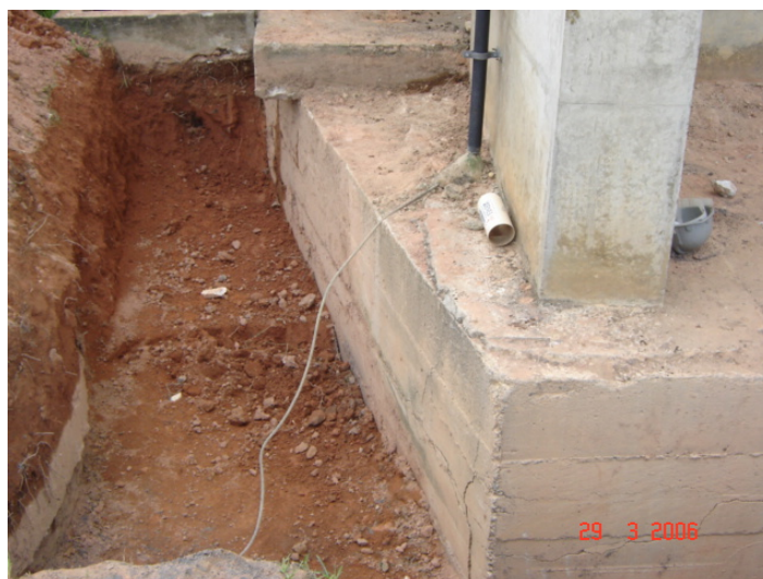
Figura 5.2 – Escavação preliminar para inspeção visual do bloco.
