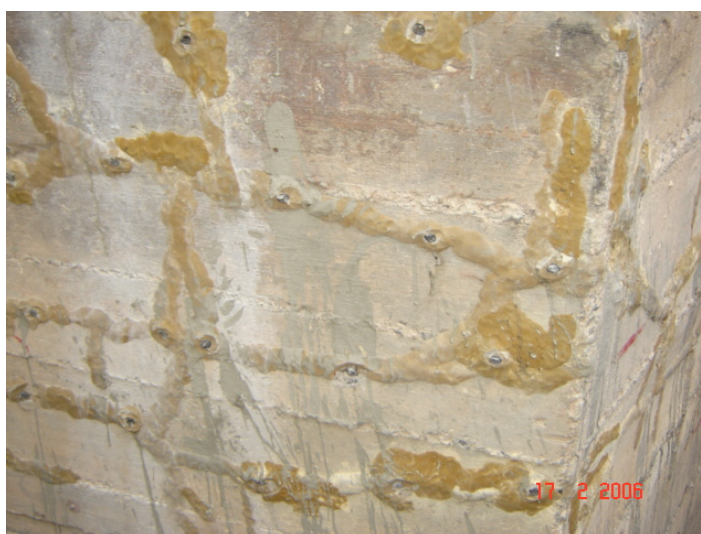
Figura 5.54 – Corte dos purgadores rente a face do bloco.
