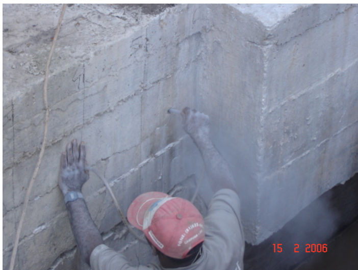
Figura 5.31 – Retirada de pó nos furos dos purgadores.
