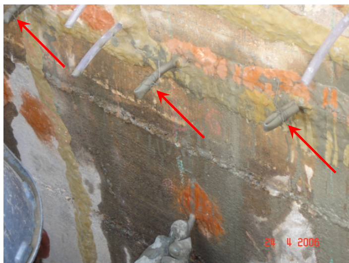
Figura 5.51 – Fechamento dos purgadores após preenchido com microcimento.
