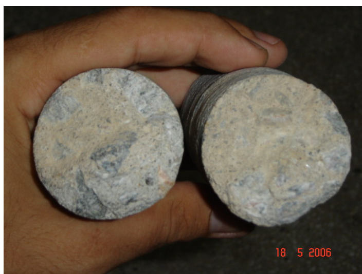
Figura 5.44 – Extração de testemunho depois da lavagem das trincas.
