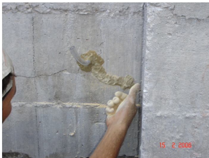
Figura 5.36 – Aplicação da argamassa de epóxi misturado com caulim.
