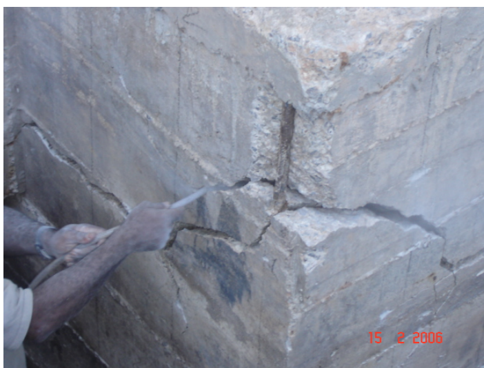
Figura 5.32 – Retirada de pó nas trincas e fissuras.
