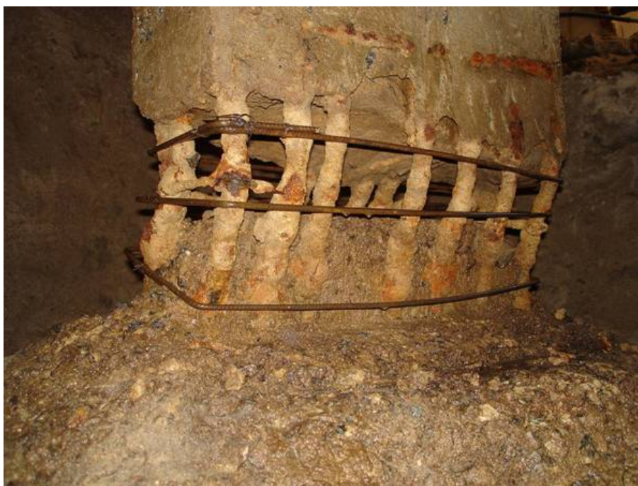
Figura 2.4 – Pescoço de outro pilar do Edifício Solar da Piedade.
