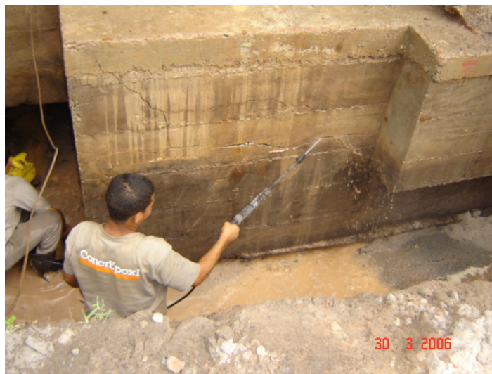
Figura 5.21 – Lavagem das faces com a lavadora de alta pressão.
