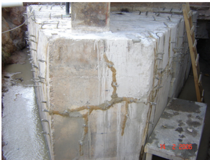
Figura 5.53 – Bloco afetado pela RAA após a Injeção de microcimento.
