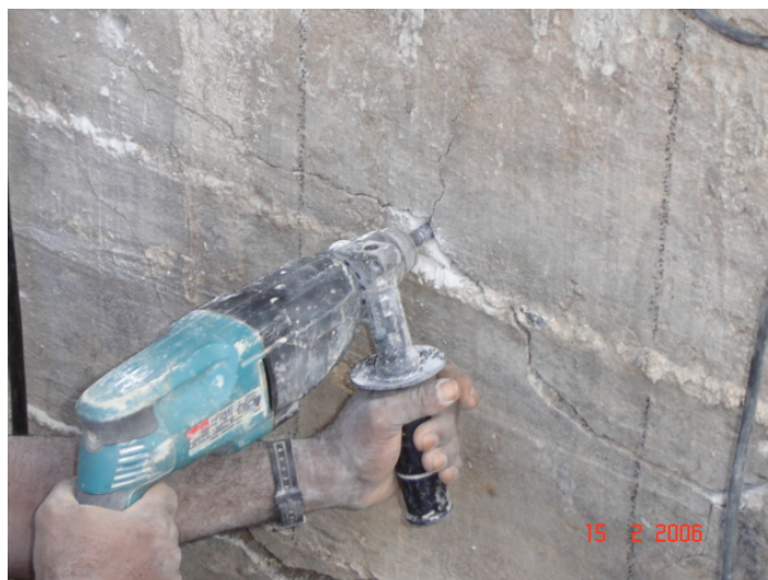
Figura 5.24 – Furação das trincas com abertura inferior a 100 mm.
