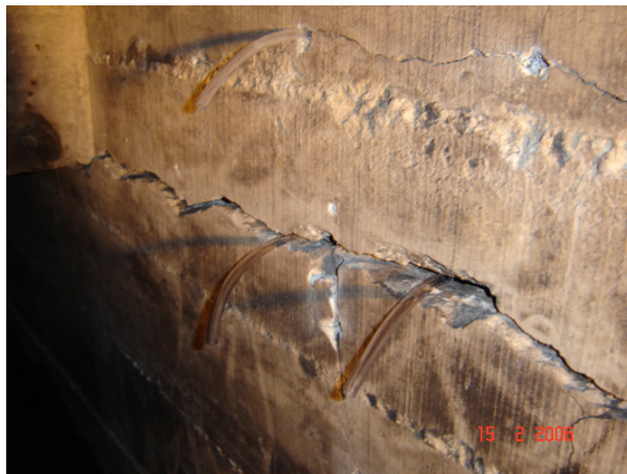
Figura 5.33 – Colocação dos purgadores nas trincas, fissuras e furos.
