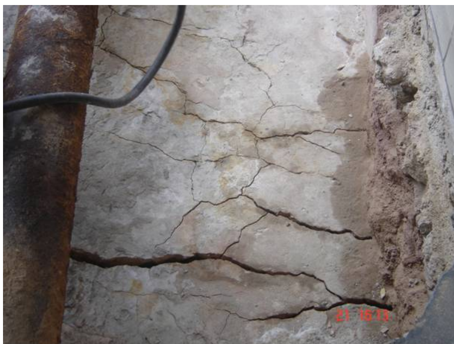
Figura 2.2 – Bloco de fundação do Edifício Apolônio Sales
