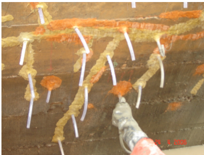
Figura 5.49 – Injeção de microcimento pelo furo de 2”.
