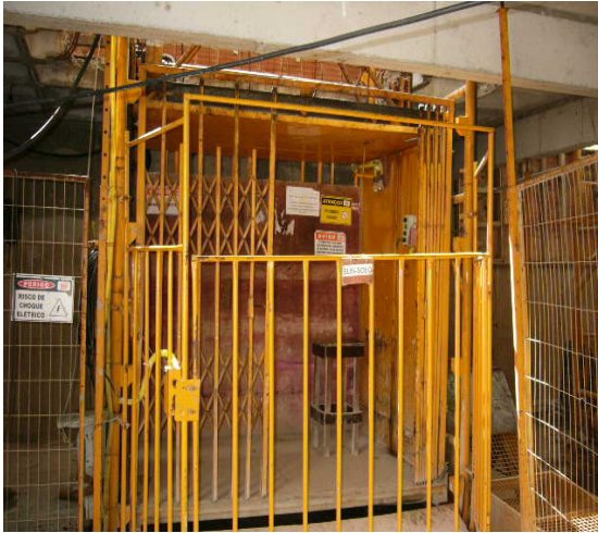
Foto 1: Guincho de Obra
